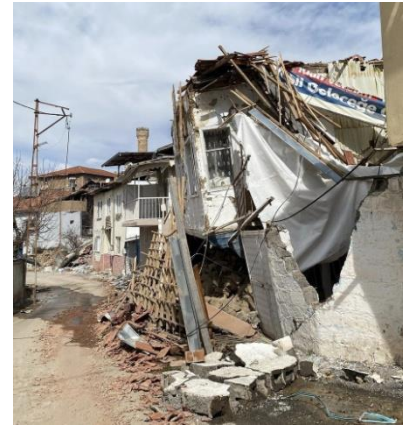
Şekil 25. Gündüzbey’ de bulunan yığma yapıların tipik hasar görüntüleri (Yeşilyurt, Malatya)
