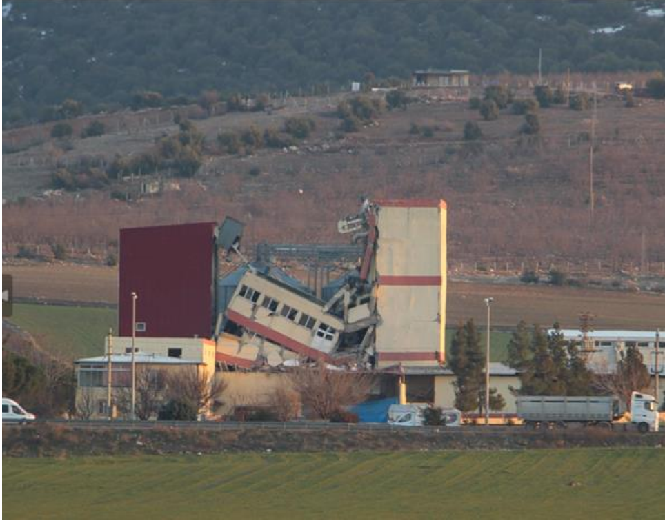
Şekil 31. Kısmi göçme olmuş fabrika yapısı (Pazarcık, Kahramanmaraş)
