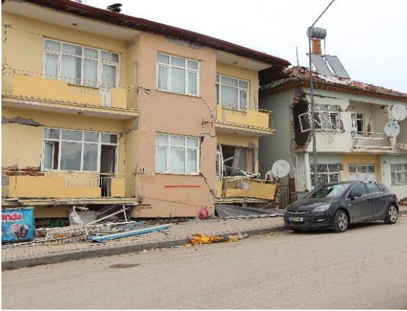
Şekil 26. Doğanşehir’de bulunan yapılarda yumuşak kat oluşumu (Doğanşehir, Malatya)
