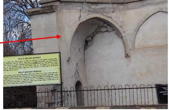
Şekil 34. Sütü Minare’de oluşan hasarlar (Battalgazi, Malatya)
