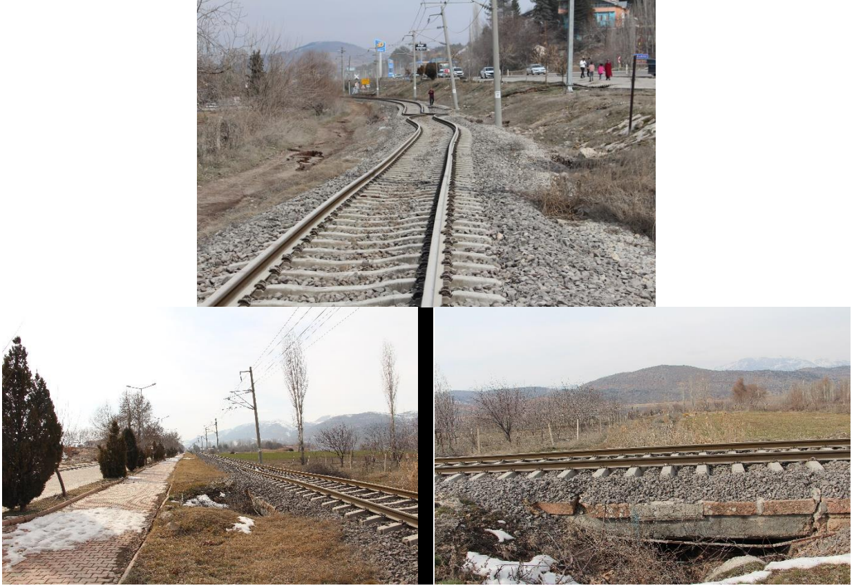
Şekil 41. Gölbaşı demiryolu deformasyonu (Adıyaman)
