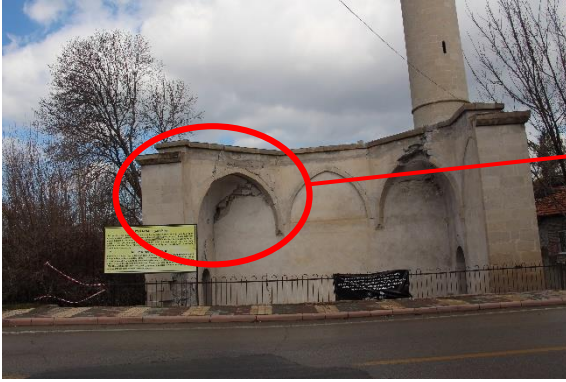
Şekil 34. Sütü Minare’de oluşan hasarlar (Battalgazi, Malatya)
