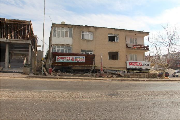
Şekil 27. Zemin kat ve normal kat seviyesinde yumuşak kat oluşumu (Pazarcık, Kahramanmaraş)
