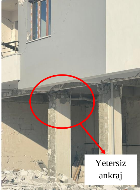
Şekil 20. Donatı detayındaki hatalar (devam)
