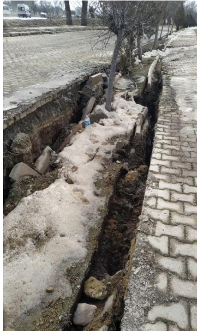
Şekil 42. Gölbaşı zemin oturması (Adıyaman)
