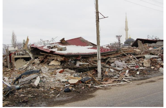
Şekil 29. Yassı kadayıf tipi göçme (Sürgü, Adıyaman)
