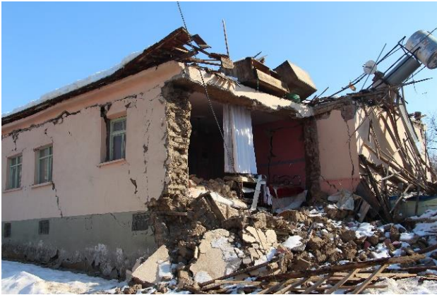
Şekil 25. Gündüzbey’ de bulunan yığma yapıların tipik hasar görüntüleri (Yeşilyurt, Malatya)
