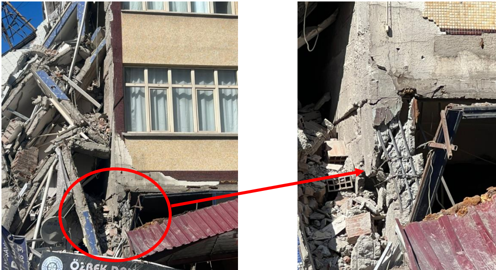
Şekil 18. Emeksiz caddesinde bitişik nizam olarak inşa edilen yapılardaki hasarlar (Malatya)
