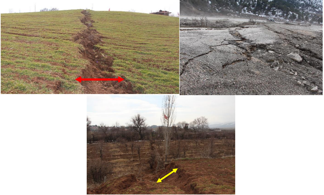
Şekil 46. Fay kırılmalarının yüzey izleri (Adıyaman-Kahramanmaraş otoyolu)
