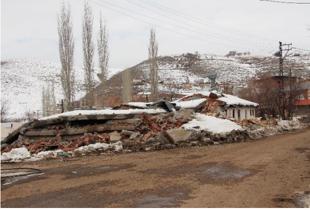
Şekil 29. Yassı kadayıf tipi göçme (Sürgü, Adıyaman)
