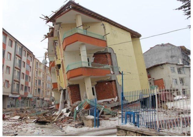
Şekil 26. Doğanşehir’de bulunan yapılarda yumuşak kat oluşumu (Doğanşehir, Malatya)
