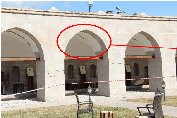
Şekil 37. Kervansaray’ da oluşan hasarlar (Battalgazi, Malatya)
