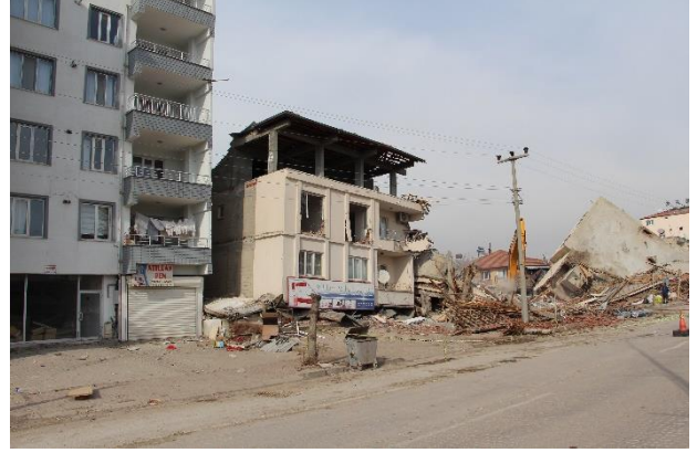
Şekil 27. Zemin kat ve normal kat seviyesinde yumuşak kat oluşumu (Pazarcık, Kahramanmaraş)
