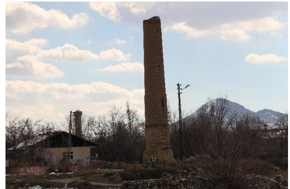
Şekil 35. Tarihi camilerde oluşan tipik minare hasarları (Battalgazi, Malatya)
