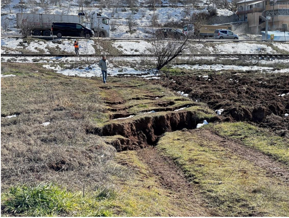
Şekil 4.34 Adıyaman Gölbaşı ilçesi yumuşak kil tabakada yanal deformasyonlar
