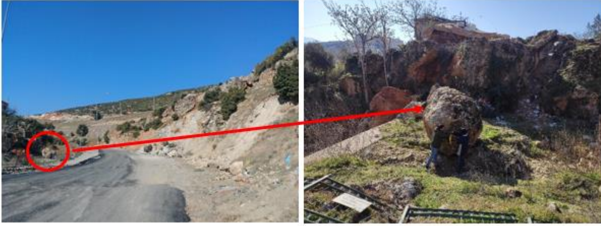
Şekil 4.8. Kaya kopmaları ve düşmelerinin bazılarının yolun diğer yakasına geçtiği anlaşılmaktadır.
