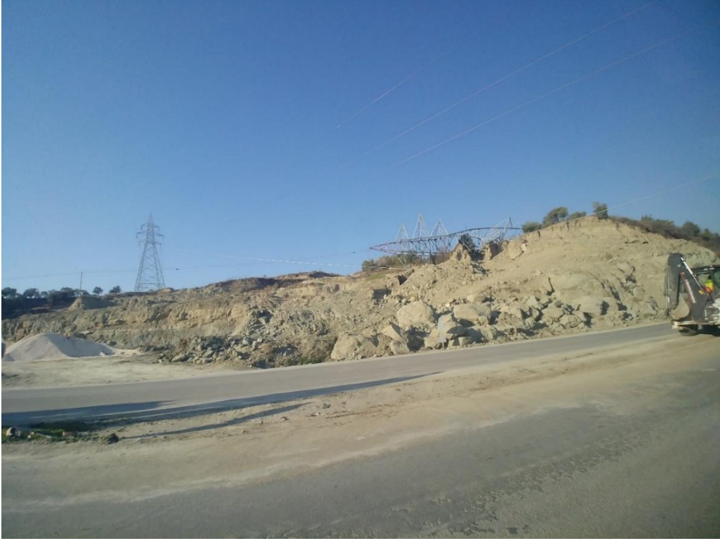
Şekil 4.11 Defne-Hatay’da yol boyunca izlenen kaya kopmaları ve düşmeleri.
