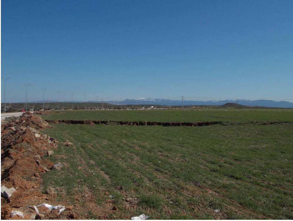
Şekil 4.31 Gaziantep İslahiye ilçesi fay atım dolayısı ile oluşan zemin deformasyonu
