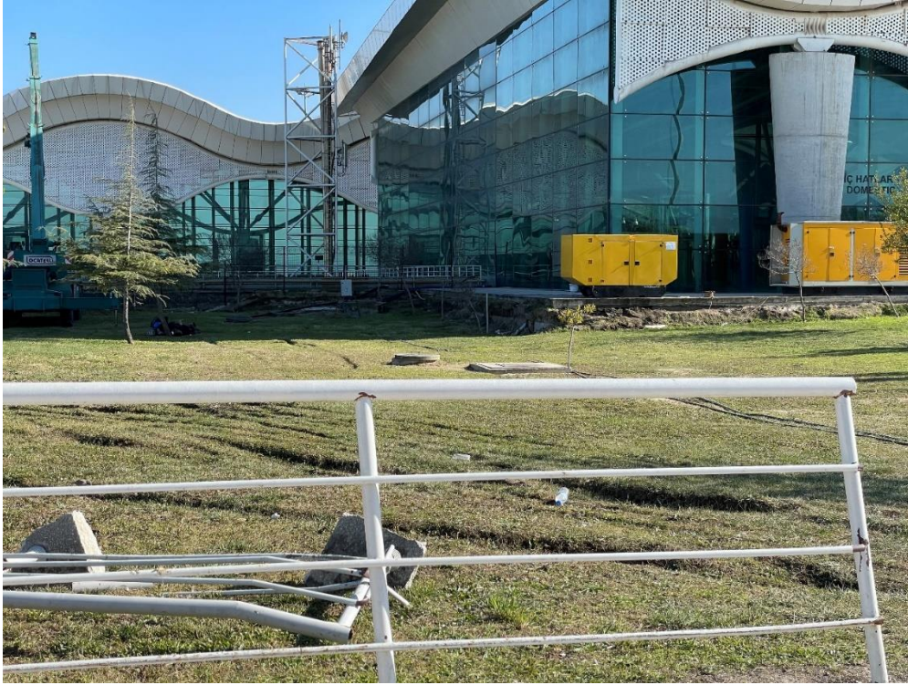
Şekil 4.39 Hatay havalimanı binası bahçesindeki sıvılaşma kaynaklı oturmalar (yaklaşık 1 metre)
