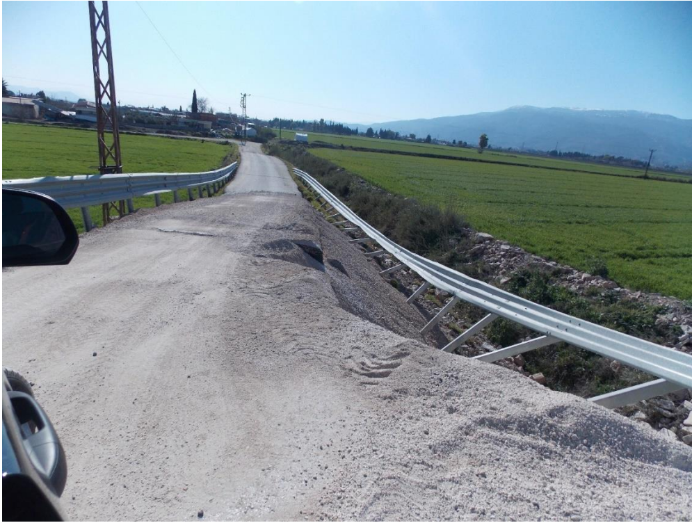
Şekil 4.24 Hatay havalimanı erişim yolu dolgusu stabilite sorunları (yanal yayılmalar)
