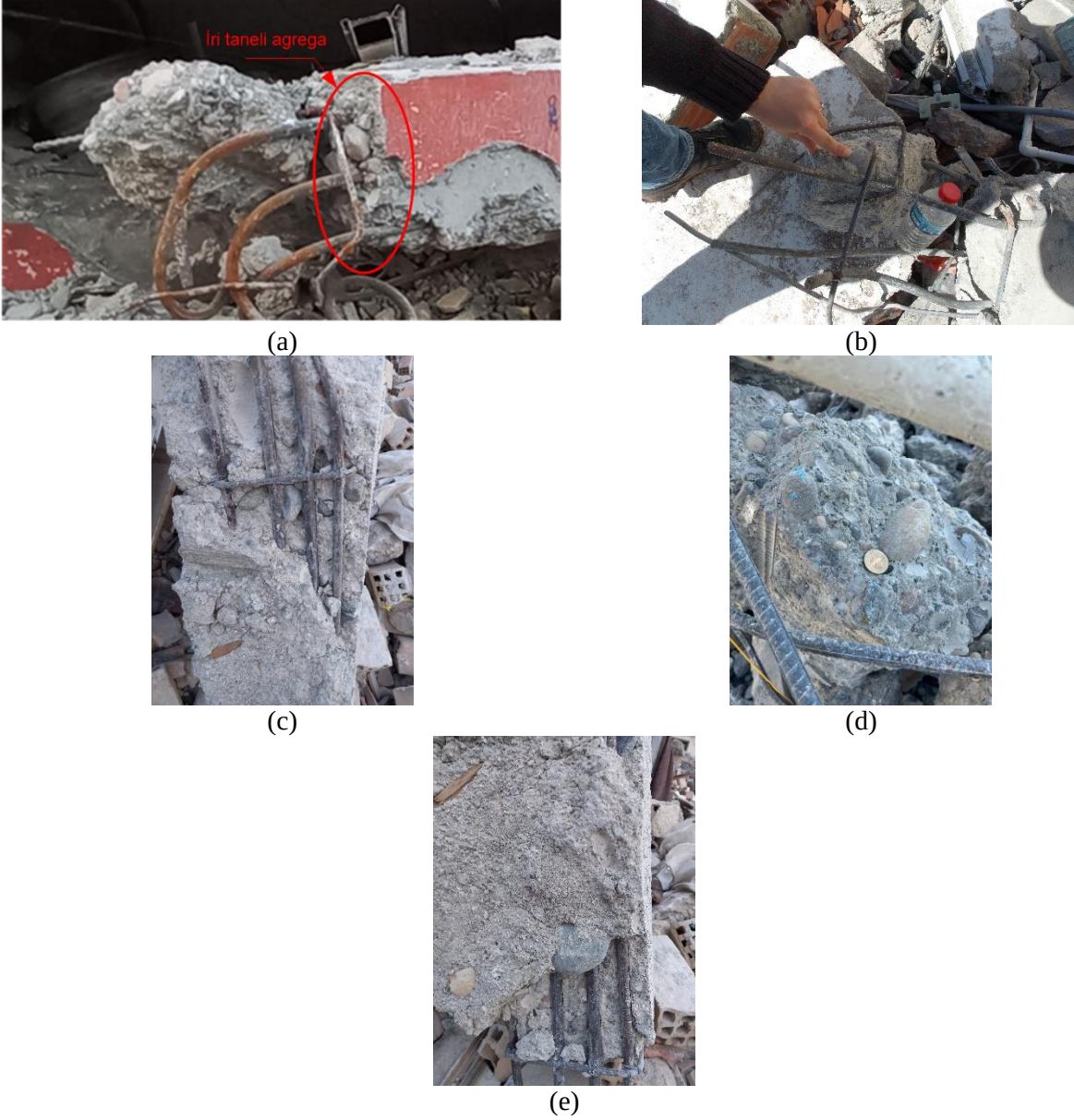
Şekil 5.3 Betonda kullanılan iri malzeme a,d) Kahramanmaraş b) Gölbaşı c,e) Hatay
