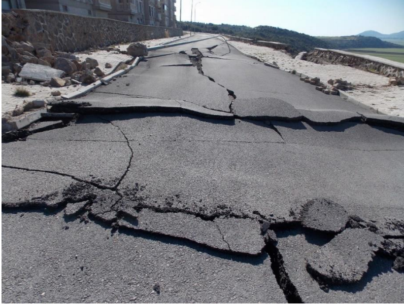
Şekil 4.14 Gaziantep İslâhiye ilçesi Fevzipaşa 3. Etap TOKİ konutları dolgu şevde yanal deformasyonlar
