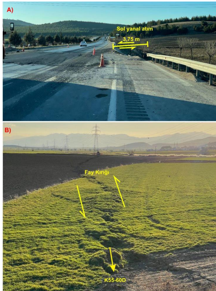
Şekil 2.6 a) Pazarcık segmentinin Kahramanmaraş-Gaziantep ana yolunu kestiği bölümde yarattığı 3.75 m’lik deformasyon b) Yolun güneyinde tarla içinde izlenen K55-60°D doğrultulu fay kırığı
