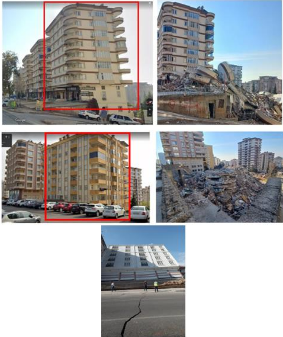
Şekil 5.13 Tamamen yıkılan binalar
