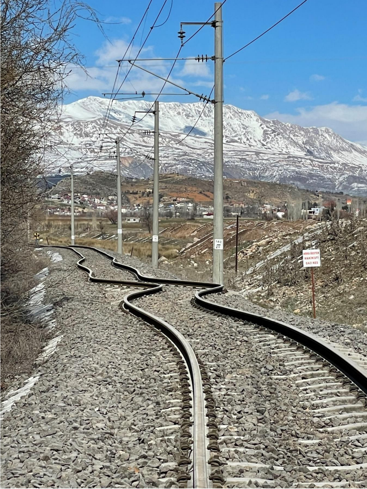
Şekil 4.33 Adıyaman Gölbaşı ilçesi yol dolgusu heyelanı nedeni ile demiryolundaki deformasyonlar
