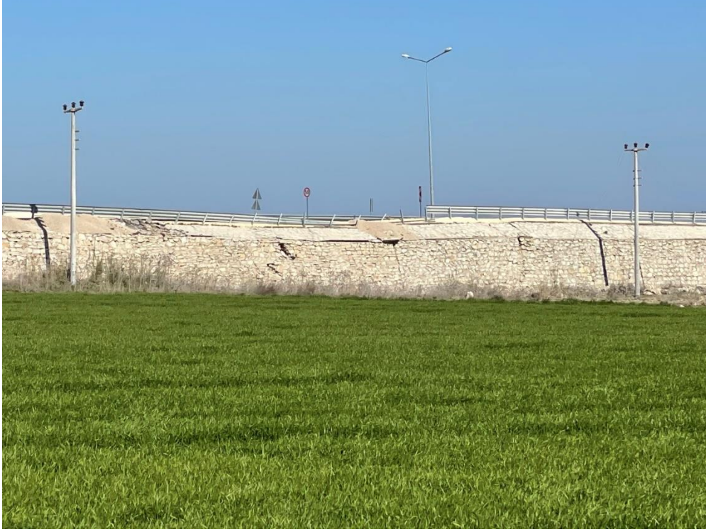
Şekil 4.23 Hatay havalimanı erişim yolu dolgusu stabilite sorunları (yanal yayılmalar)
