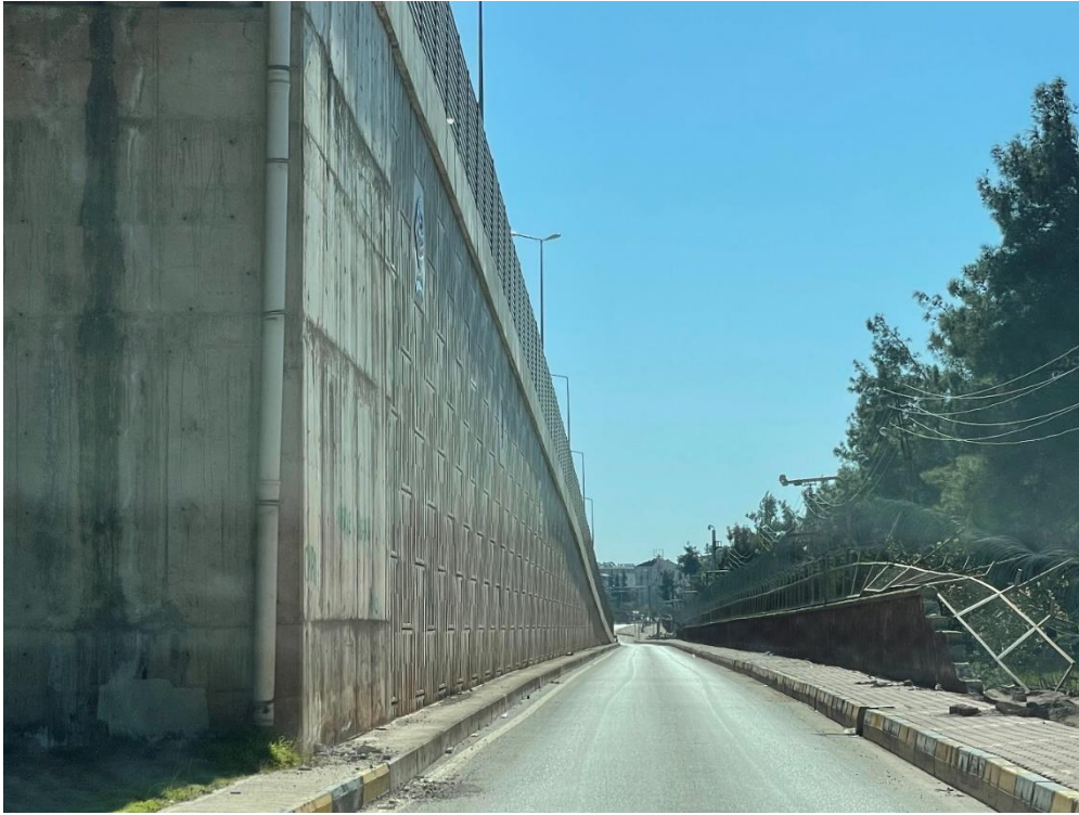
Şekil 4.19 Gaziantep İslâhiye ilçesi merkezinde faya 500 metre mesafedeki bir toprakarme duvar. Herhangi bir deformasyon ölçülmemiştir.
