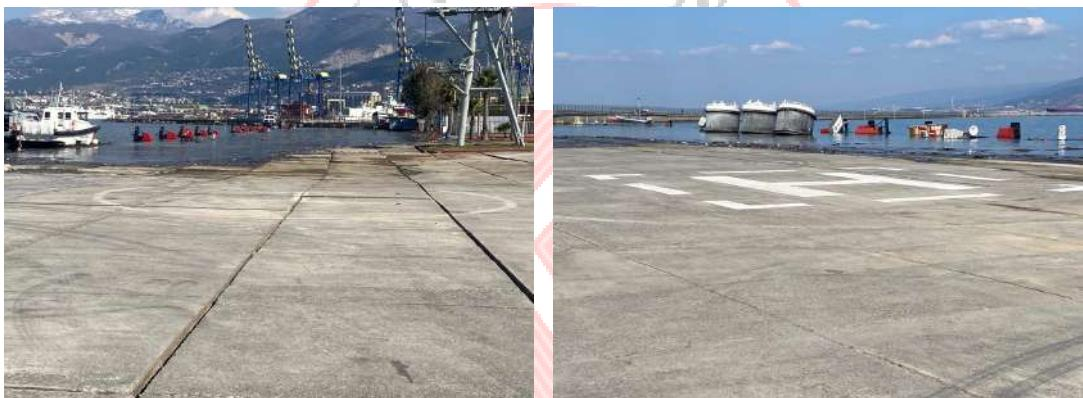
Şekil 4.55. Sismik zemin sıvılaşmasına bağlı olarak gelişen akma türü sıvılaşma davranışları nedeniyle rıhtımın denize doğru sürüklelenmesi
