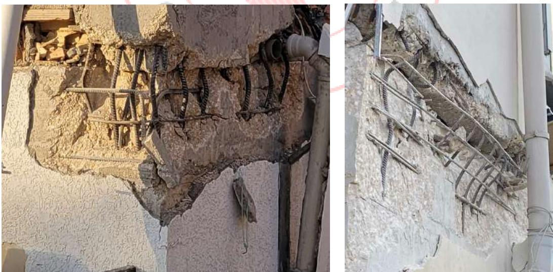
Şekil 4.10. Kolon-kiriş birleşimlerinde yetersiz etriye sıklaştırması
