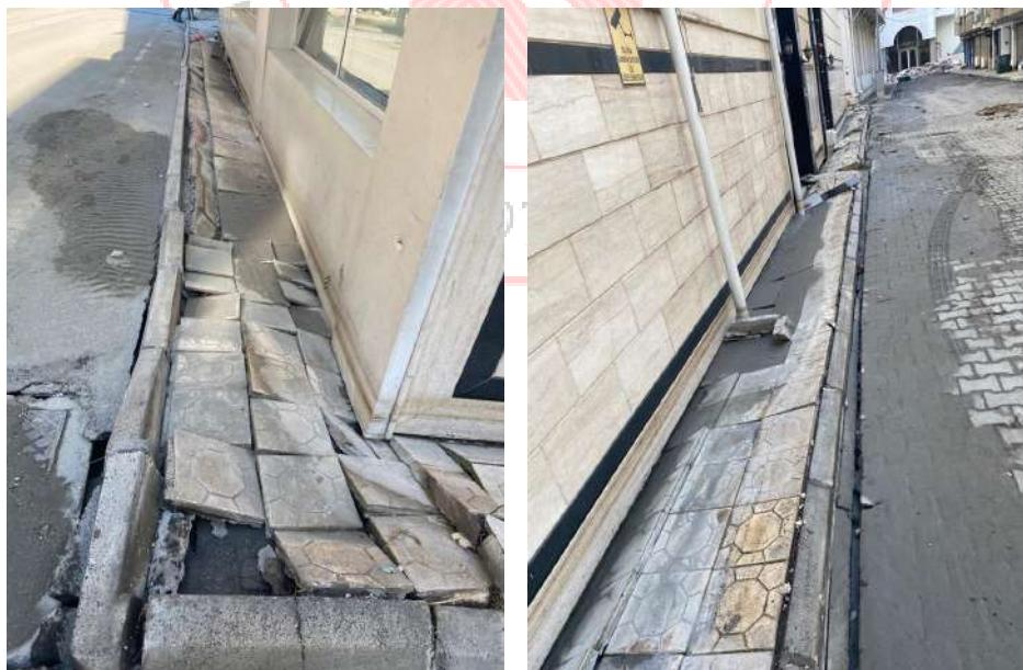
Şekil 4.53. Sismik sivilaşma zemin yenilmesi kaynaklı yanal yayılma ve aşırı hacimsel oturmalar
