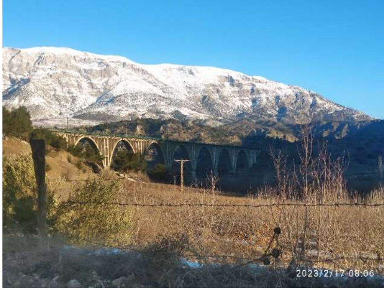
Şekil 16 Adıyaman Alman Köprüsü
