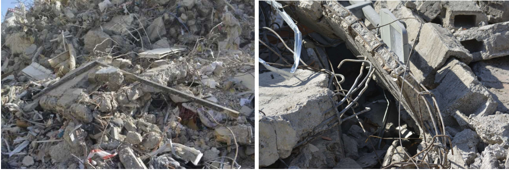
Şekil 4 2000 öncesi yapılarda Standart Dışı Malzeme Kullanımı
