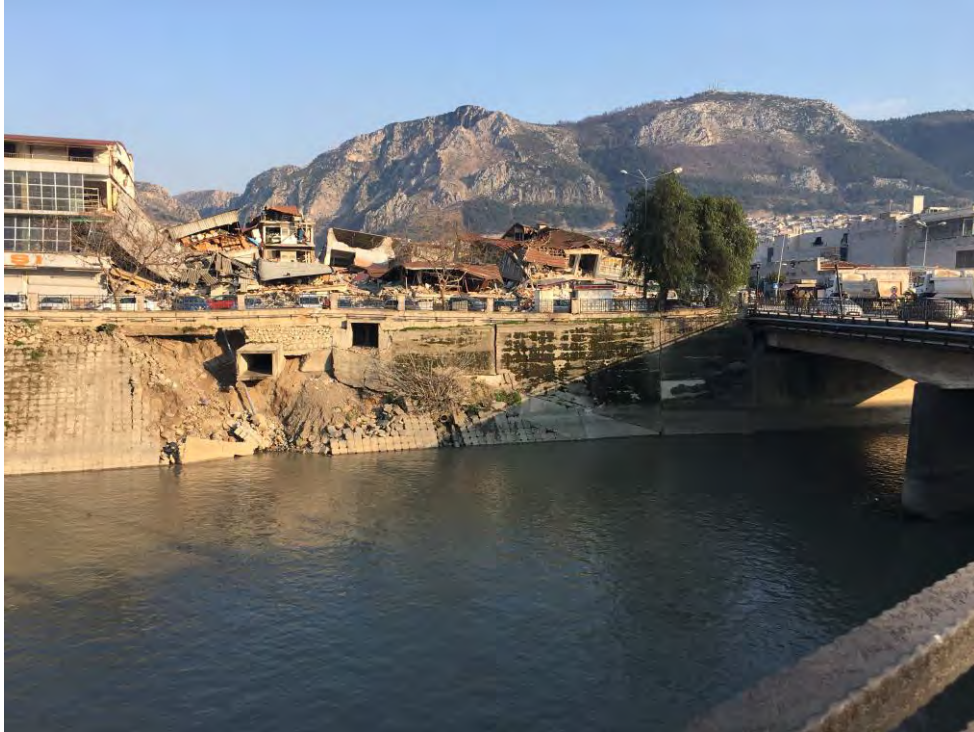
Şekil 73. Hatay’da Asi nehri boyunca dayanma yapılarında hasarlar
