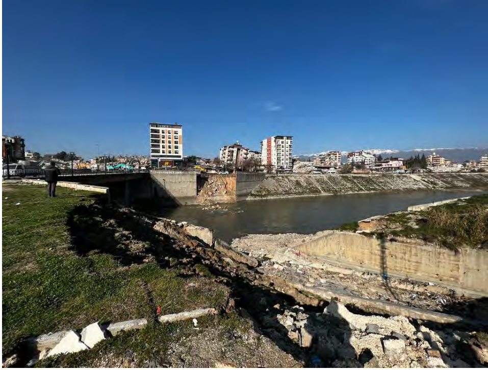
Şekil 71. Hatay'da Asi nehri boyunca alüvyal zeminde oturmalar ve dayanma yapılarında yanal yayılmalara bağlı hasarlar
