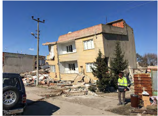
Şekil 49. Yumuşak kat düzensizliği ve ağır çıkmalar sonucunda oluşan hasarlar
