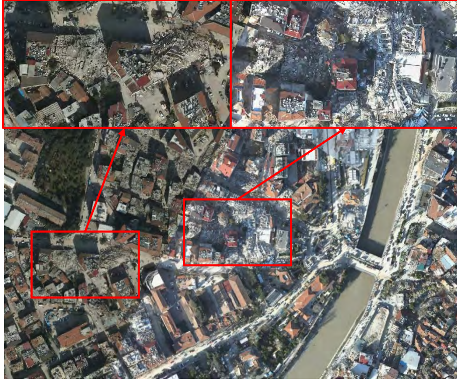
Deprem sonrası Defne ilçesinin bir bölümünün havadan görüntüsü
