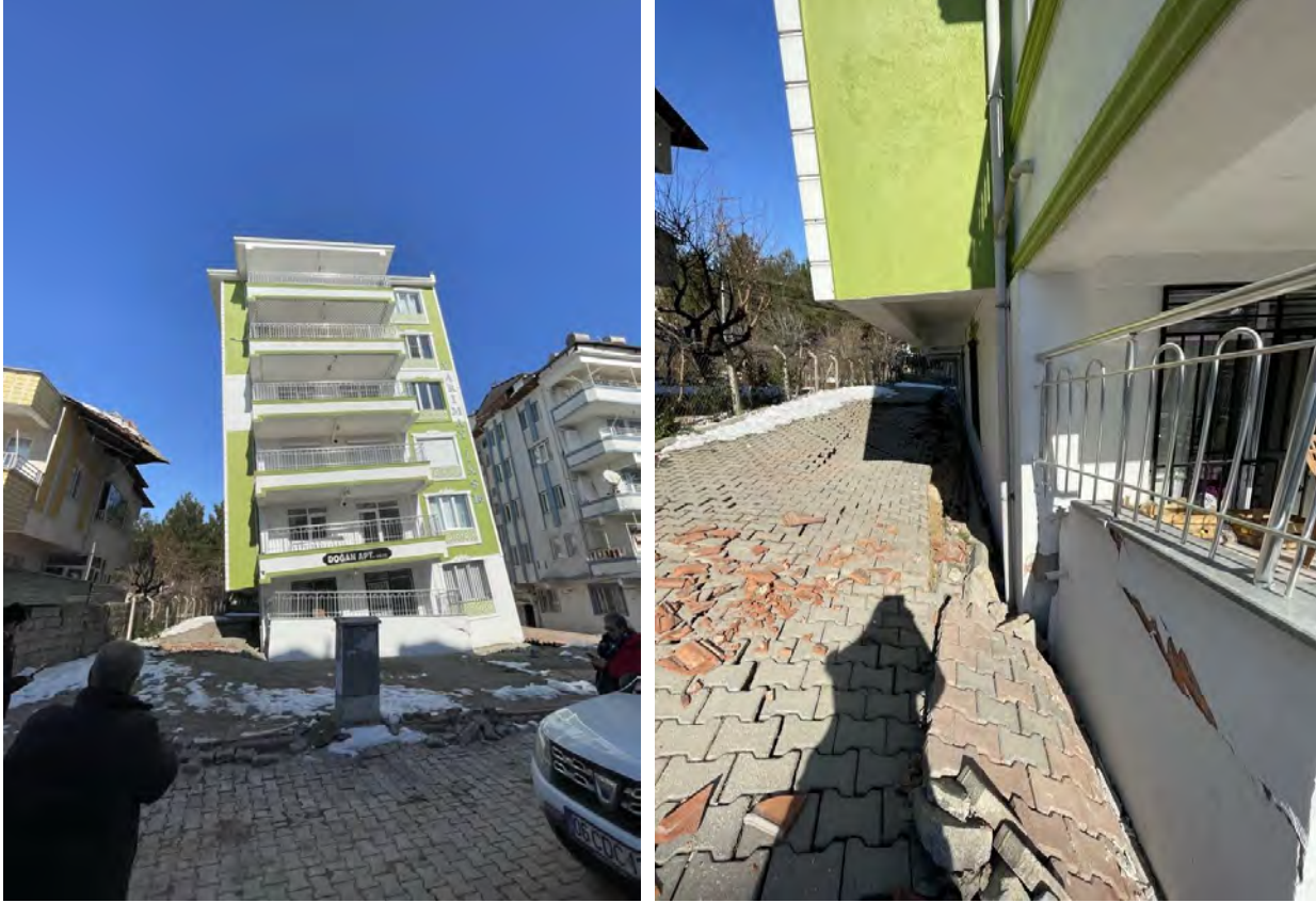
Şekil 30. Adıyaman ili Gölbaşı ilçesinde bina oturma ve eğilme örneği
