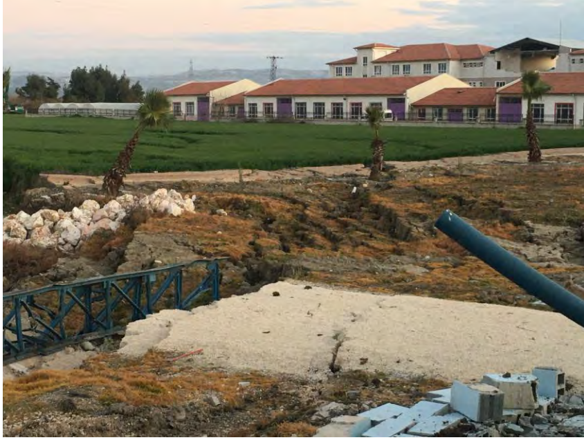
Şekil 74. Hatay çevresinde Asi ırmağı boyunca büyük yanal yayılmalar
