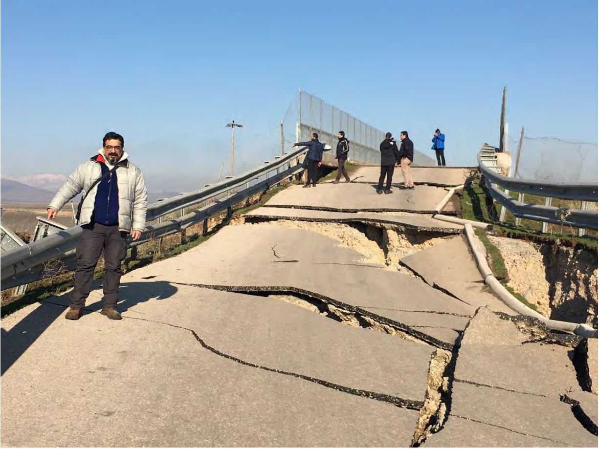
Şekil 104. Pazarcık bölgesinde yanal yayılmalar (Adana-Şanlıurfa Otoyolu Narlı girişi)
