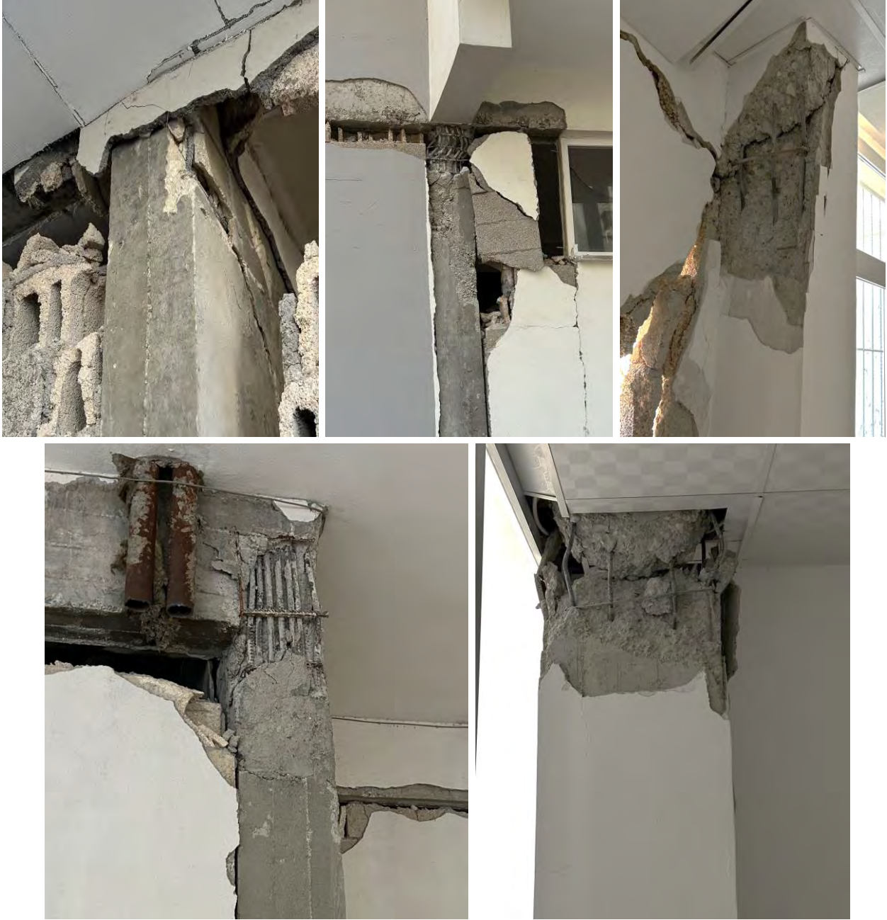
Şekil 92. Mafsallaşan kolon örnekleri
