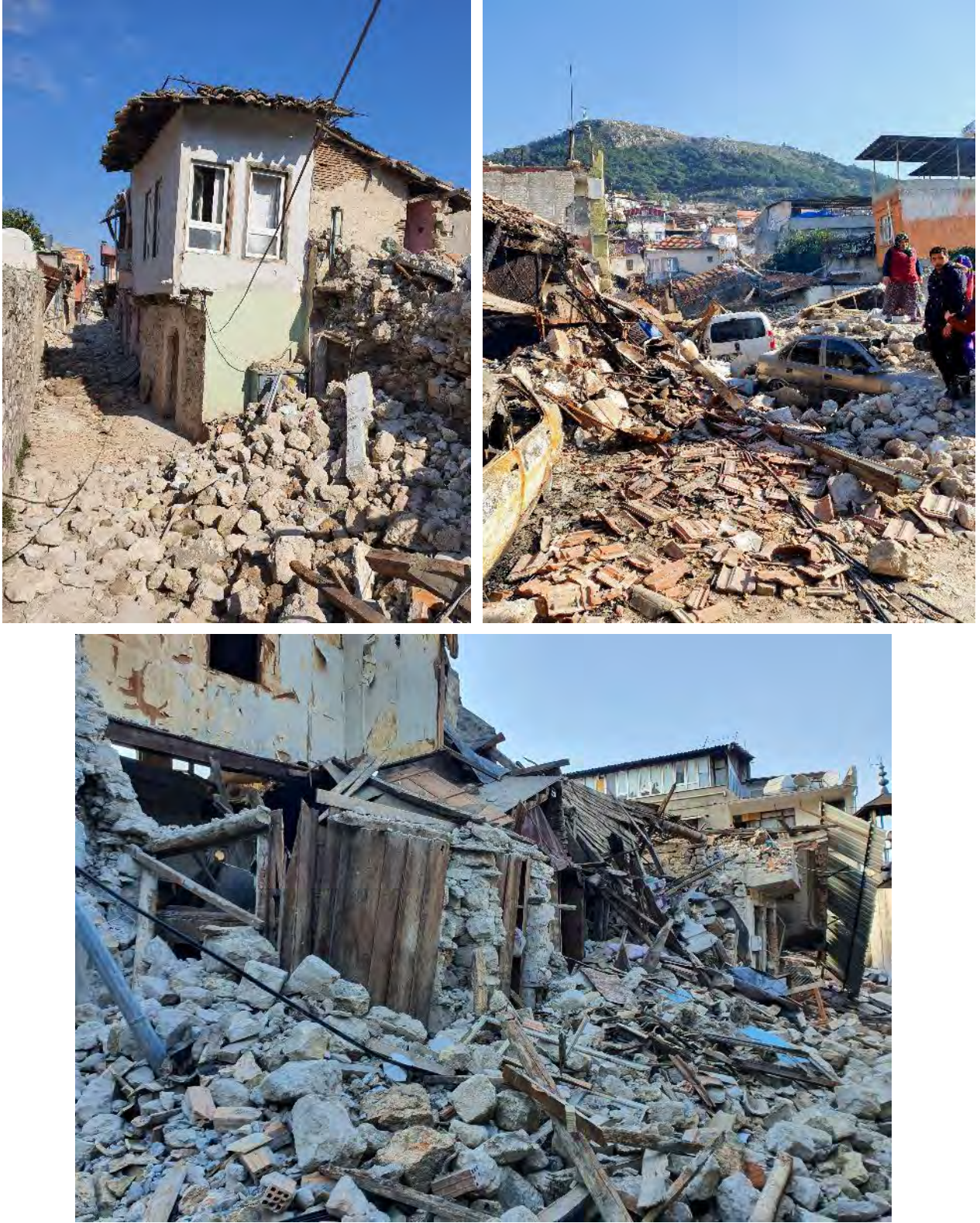
Şekil 65. Hatay ilinde yıkılan taş yığma binalar
