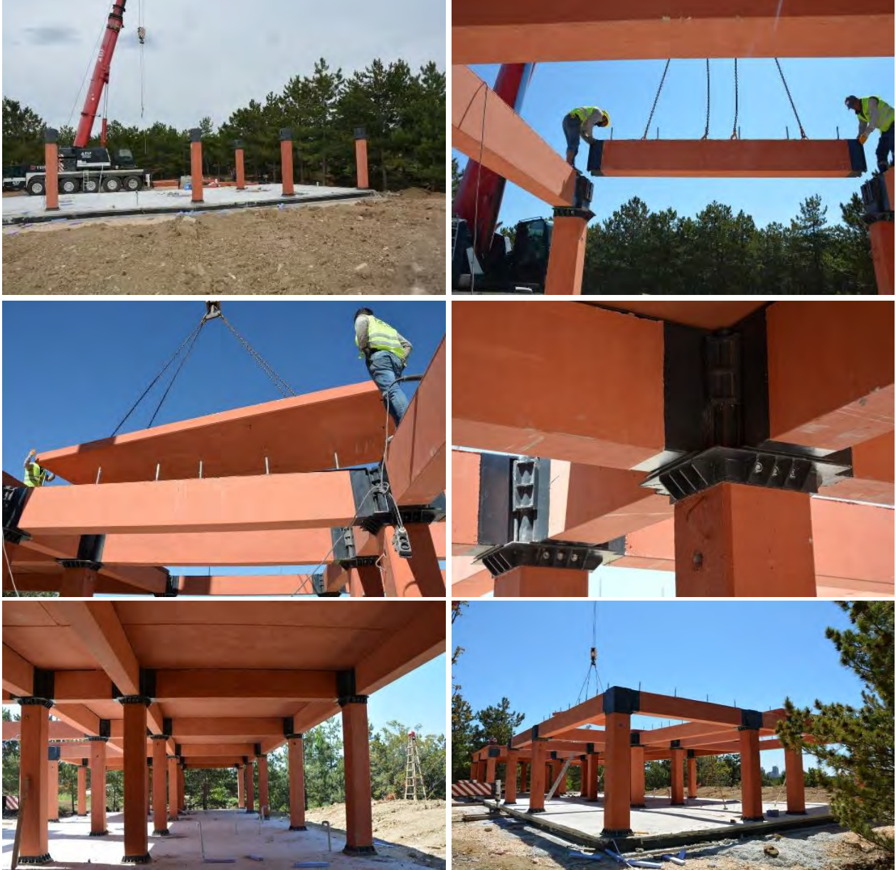
Şekil 118. İYA-esaslı malzemeler kullanılarak üretilmiş betonlar ile sökölüp-takılabilen yapı uygulaması
