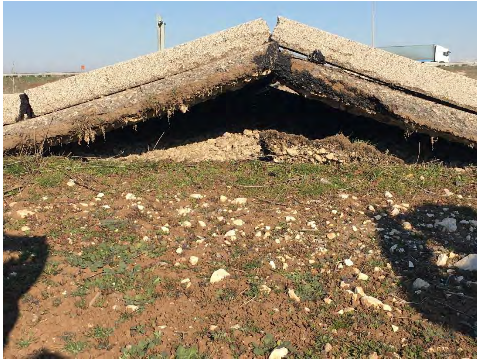
Şekil 103. Zeminlerde bağlantı yolu kaplamalarında meydana gelen hasarlar
