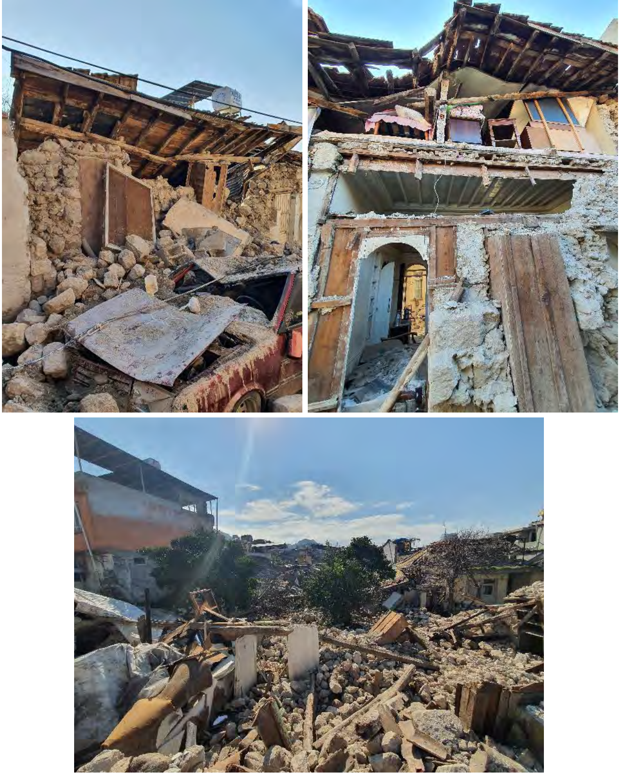
Şekil 65. Hatay ilinde yıkılan taş yığma binalar (devam)
