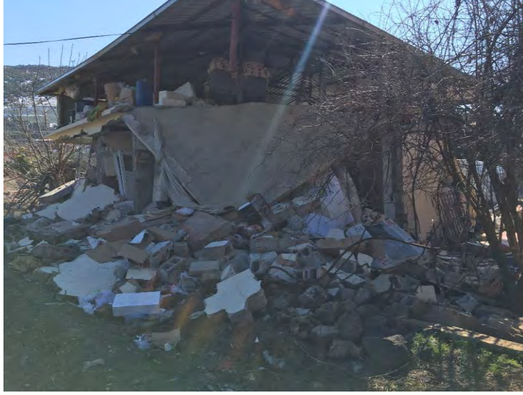
Şekil 48. Deprem sonucu yıkılan briket yığma binalar
