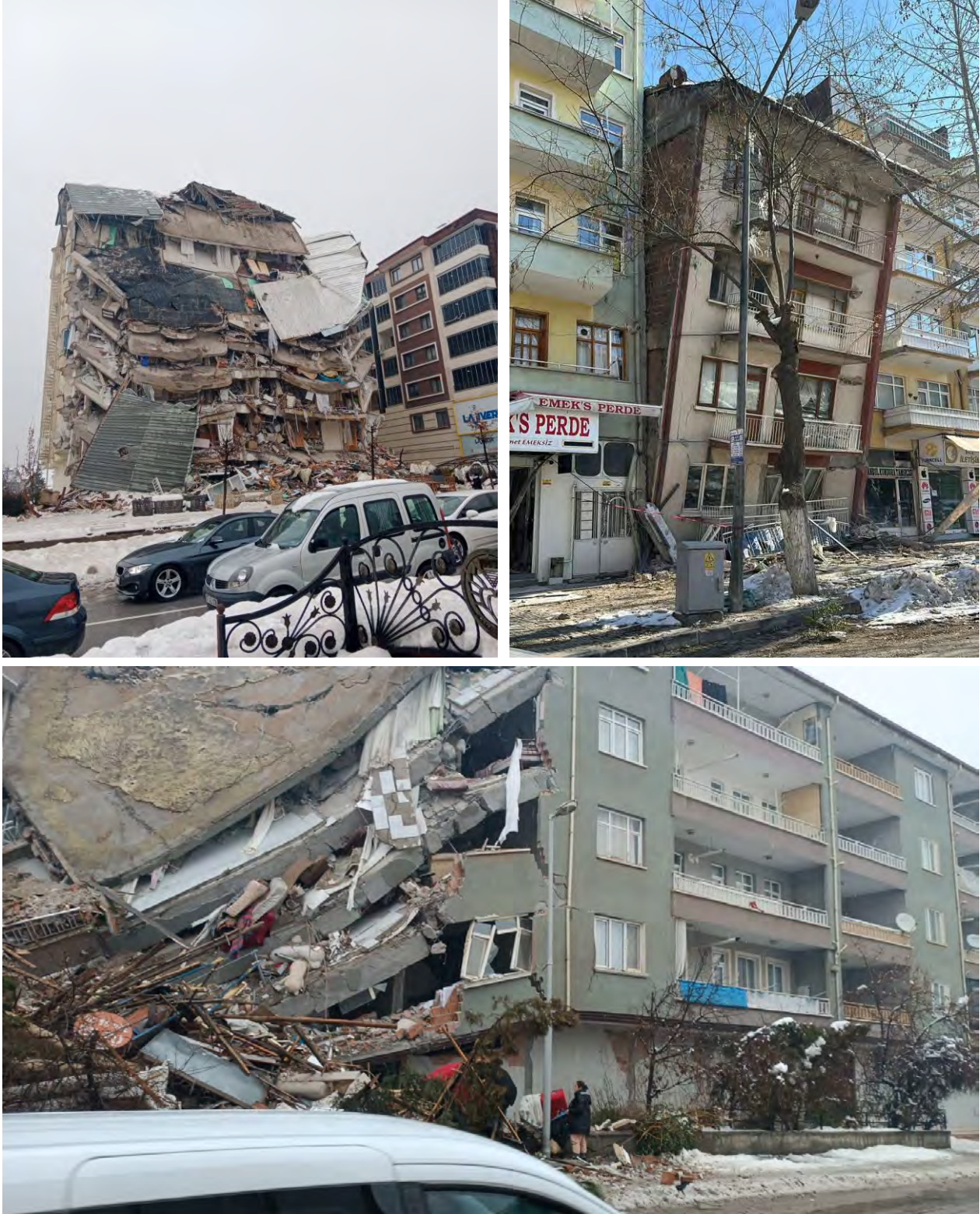
Şekil 110. Malatya ilinde yıkılan betonarme binalar (devam)
