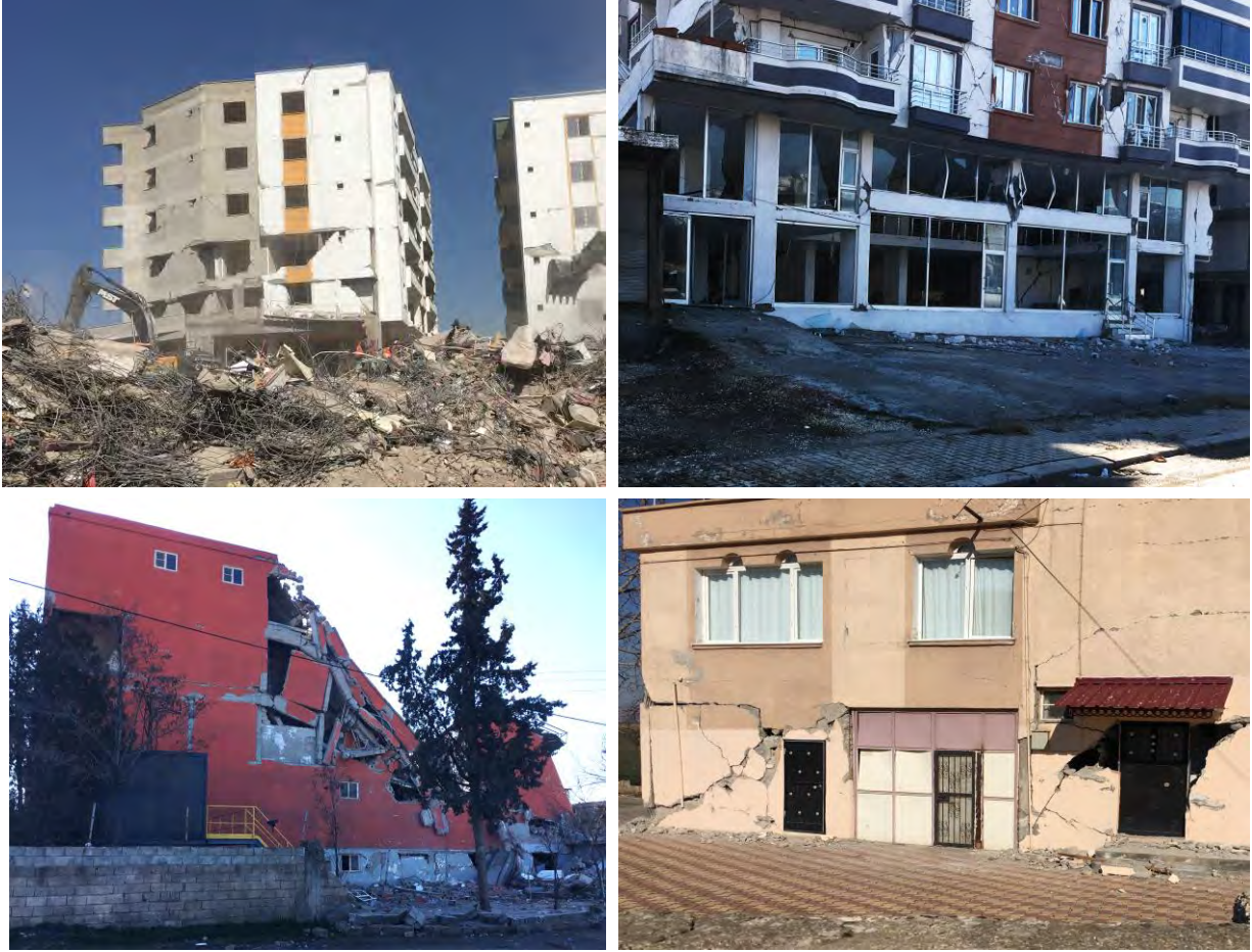
Şekil 89. Dış cephe çatlakları, örme duvar ayrılımları, kısa kolon etkisi ve bölgesel yıkım örnekleri
