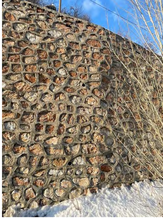
Şekil 35. Malatya – Adıyaman yolu, hasarsız taş duvar ( 37,92570^{\circ}\text{N} 37,90257^{\circ}\text{E} )
