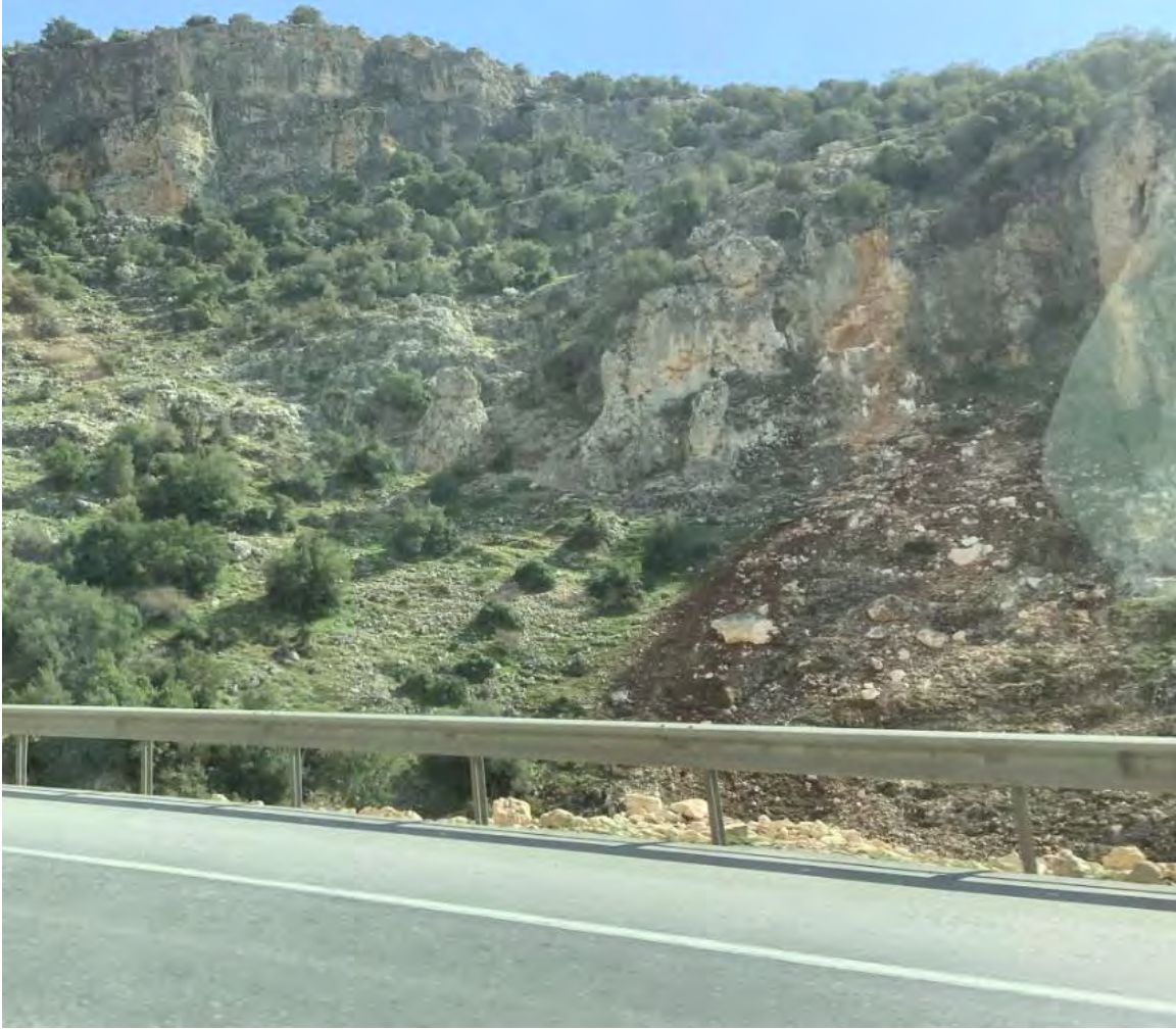
Şekil 52. Deprem sonrası şev kaymaları
