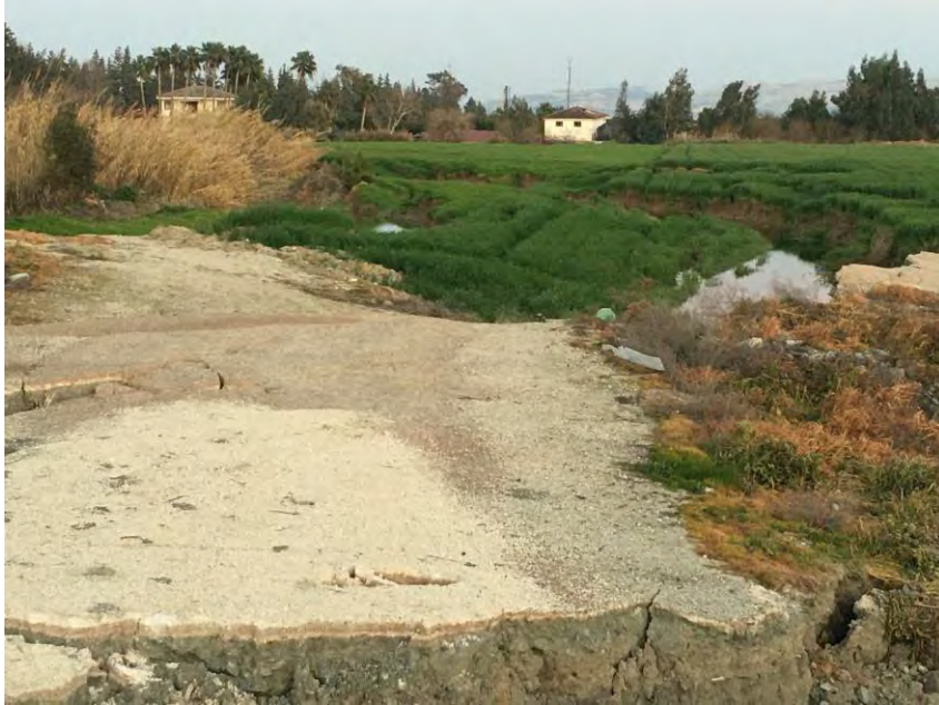
Şekil 75. Hatay çevresinde Asi ırmağı boyunca büyük yanal yayılmalar ve oturmalar
