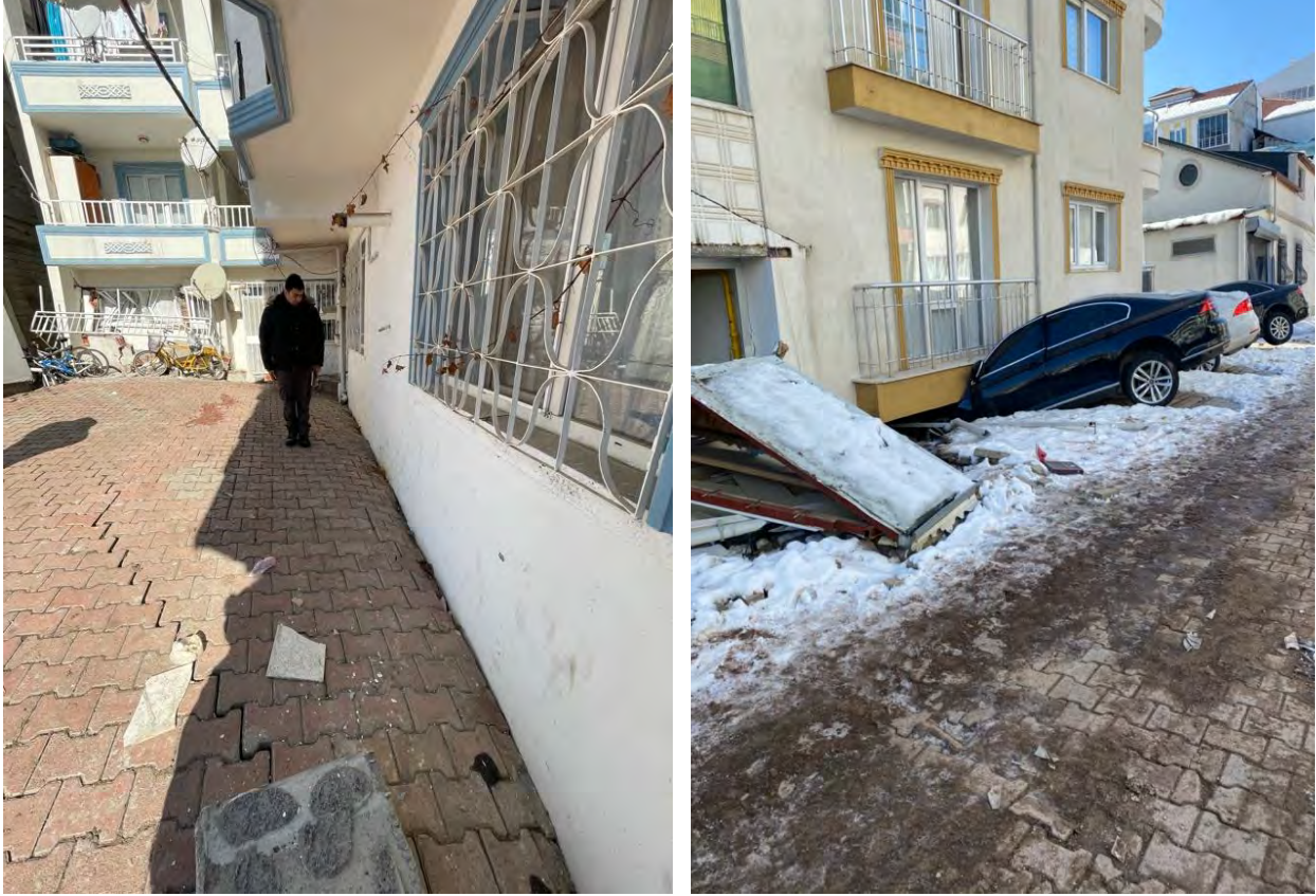
Şekil 27. Çeşitli bina oturma örnekleri (Adıyaman – Gölbaşı)
