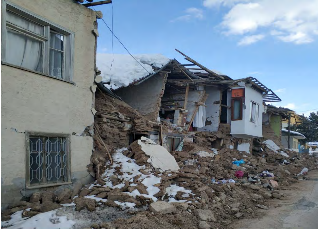
Şekil 109. Malatya ilinde yıkılan yığma binalar
