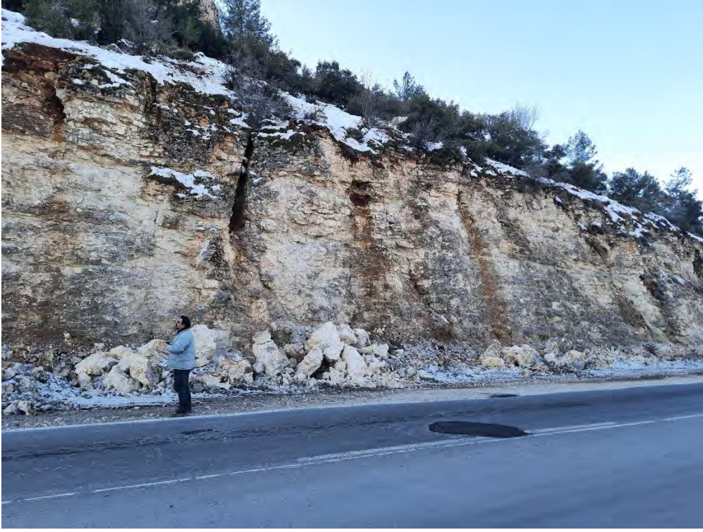
Şekil 56. Nurdağı çevresinde yol güzergahında kaya düşmesi problemleri
