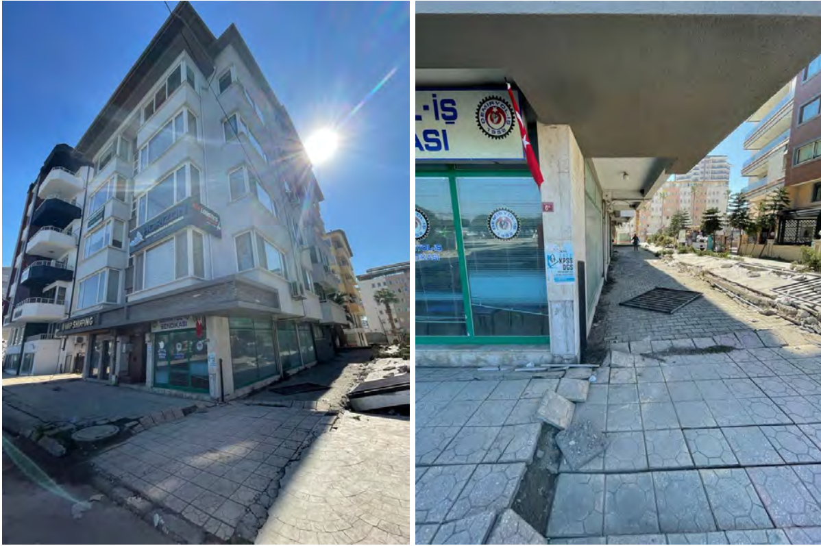
Şekil 78. İskenderun Hatay, sivilaşmaya bağlı oturma
