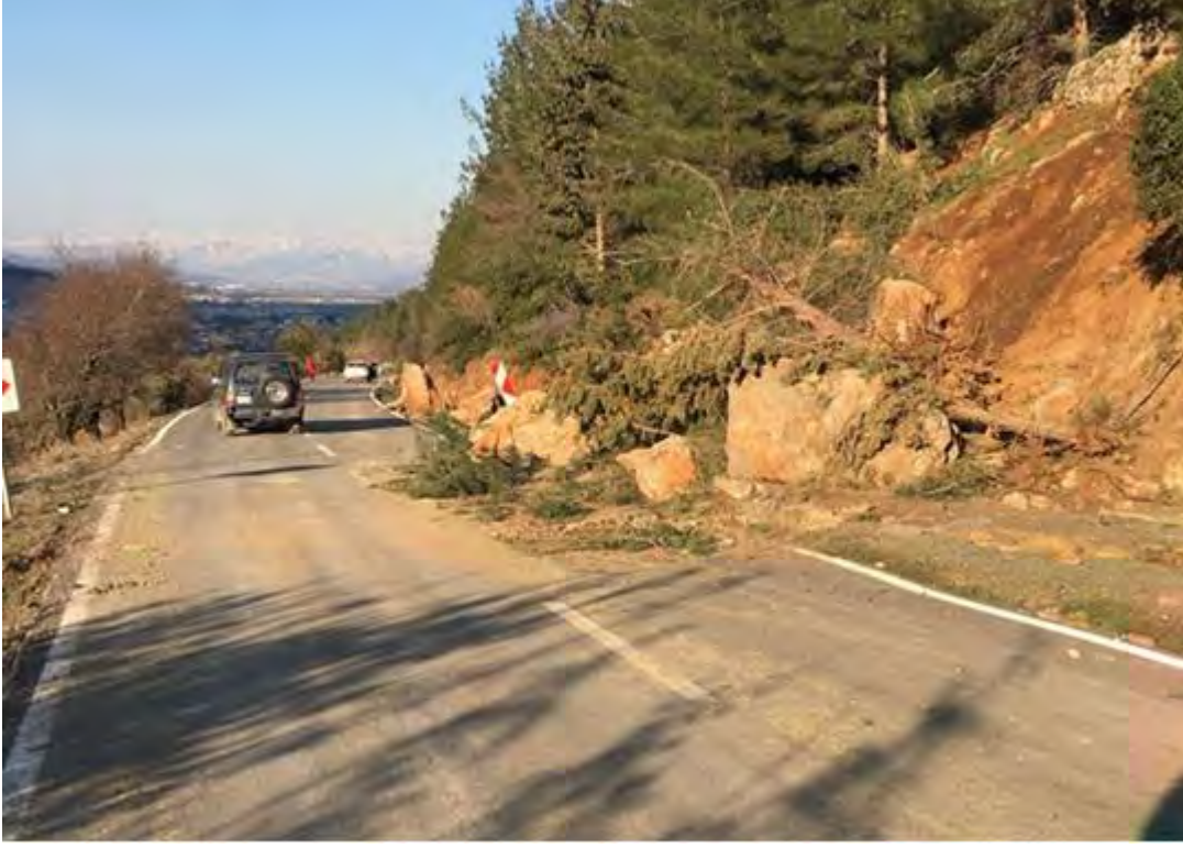
Şekil 101. Sekerova mahallesinde giden yolda kaya düşmesi ve heyelanlar
