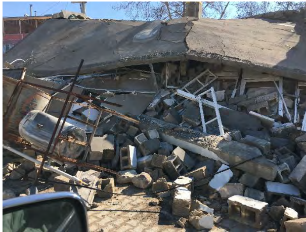
Şekil 47. Deprem sonucu yıkılan betonarme binalar
