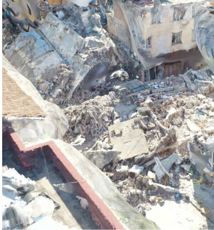
Şekil 117. Oluşturulan 3 boyutlu doku kaplamalı nokta bulutunda yıkılan bir binanın üç boyutlu enkaz temsili
