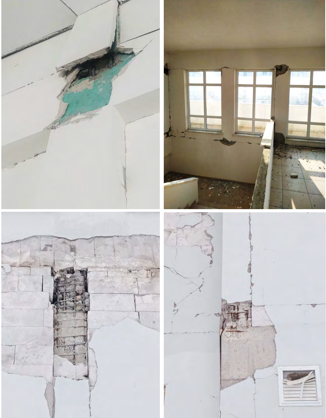
Şekil 111. Gözlemlenen kolon plastik mafsallaşma hasarları
