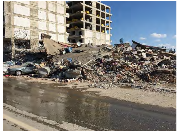
Şekil 47. Deprem sonucu yıkılan betonarme binalar
