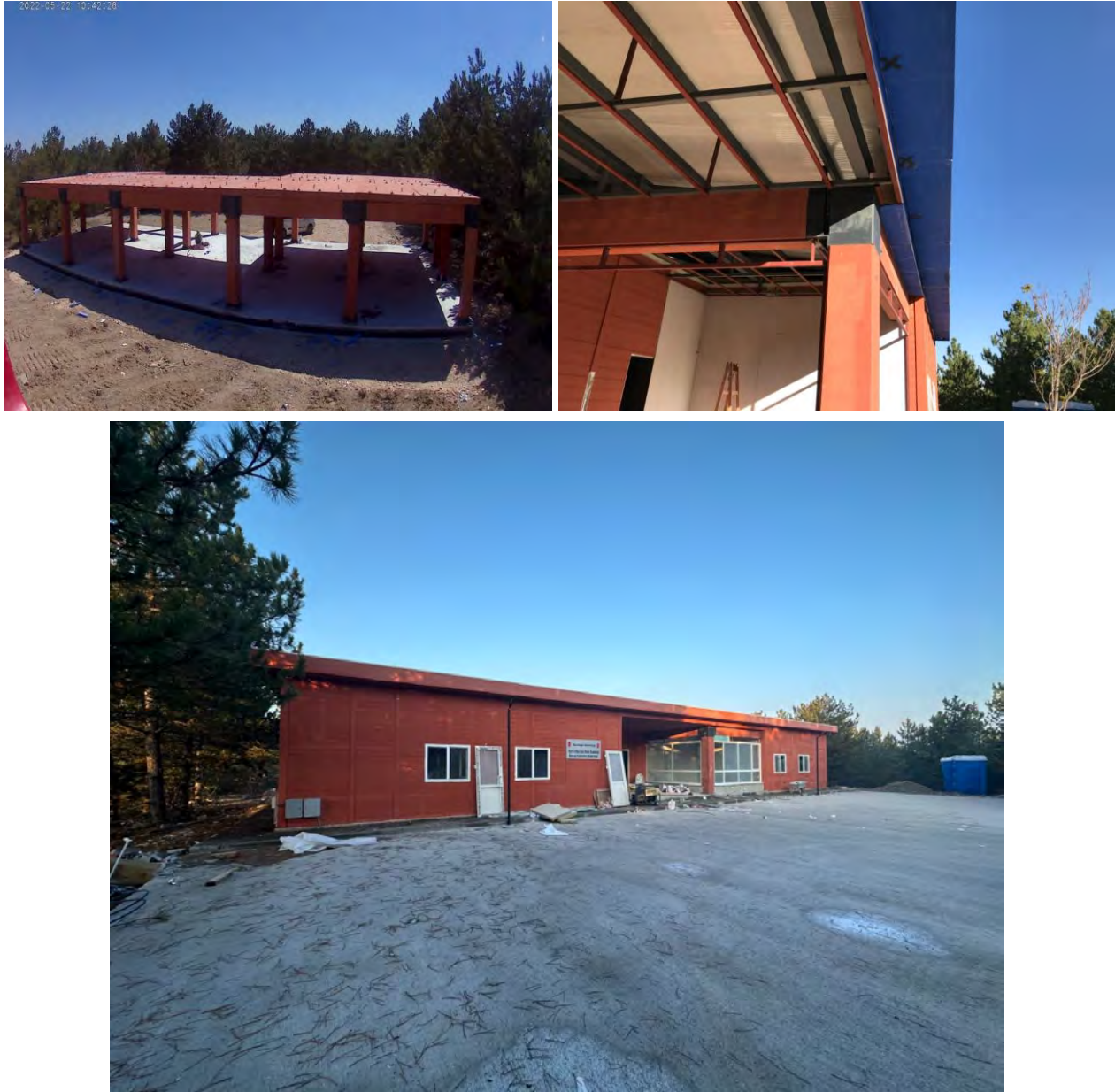
Şekil 118. İYA-esaslı malzemeler kullanılarak üretilmiş betonlar ile sökülüp-takılabilen yapı uygulaması (devam)
