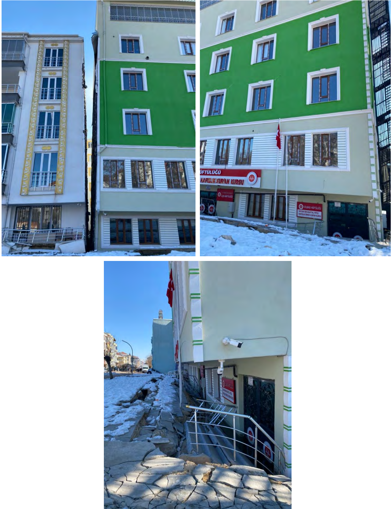
Şekil 28. Binalarda oturma kaynaklı birbirinden ayrılma örneği
