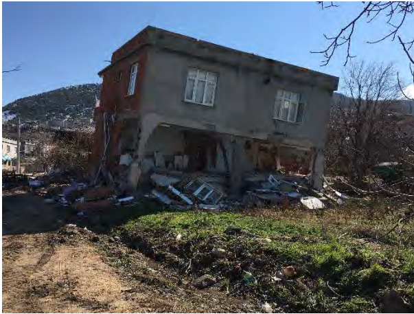
Şekil 49. Yumuşak kat düzensizliği ve ağır çıkmalar sonucunda oluşan hasarlar
