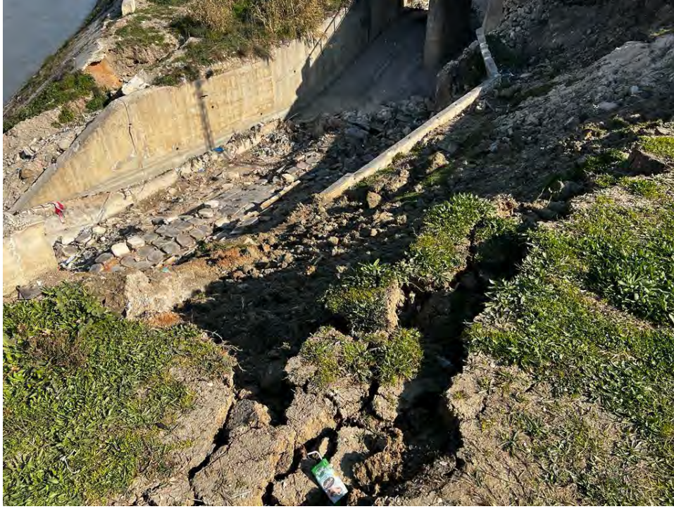
Şekil 72. Hatay’da Asi nehri boyunca alüvyal zeminde oturmalar ve yanal yayılmalar
