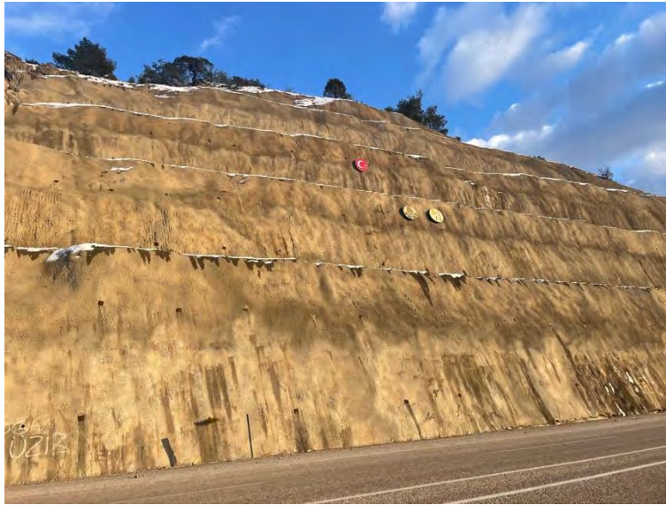
Şekil 36. Malatya – Adıyaman yolu, ankrajlı istinat yapısı ( 37,90435^{\circ}\text{N} 37,81127^{\circ}\text{E} )
