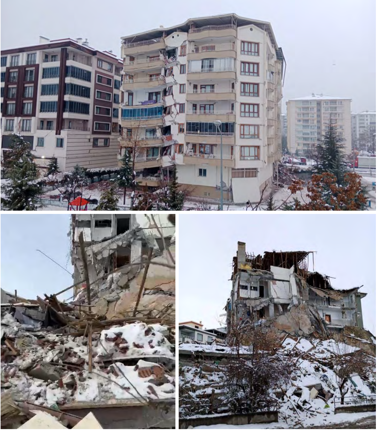
Şekil 110. Malatya ilinde yıkılan betonarme binalar
