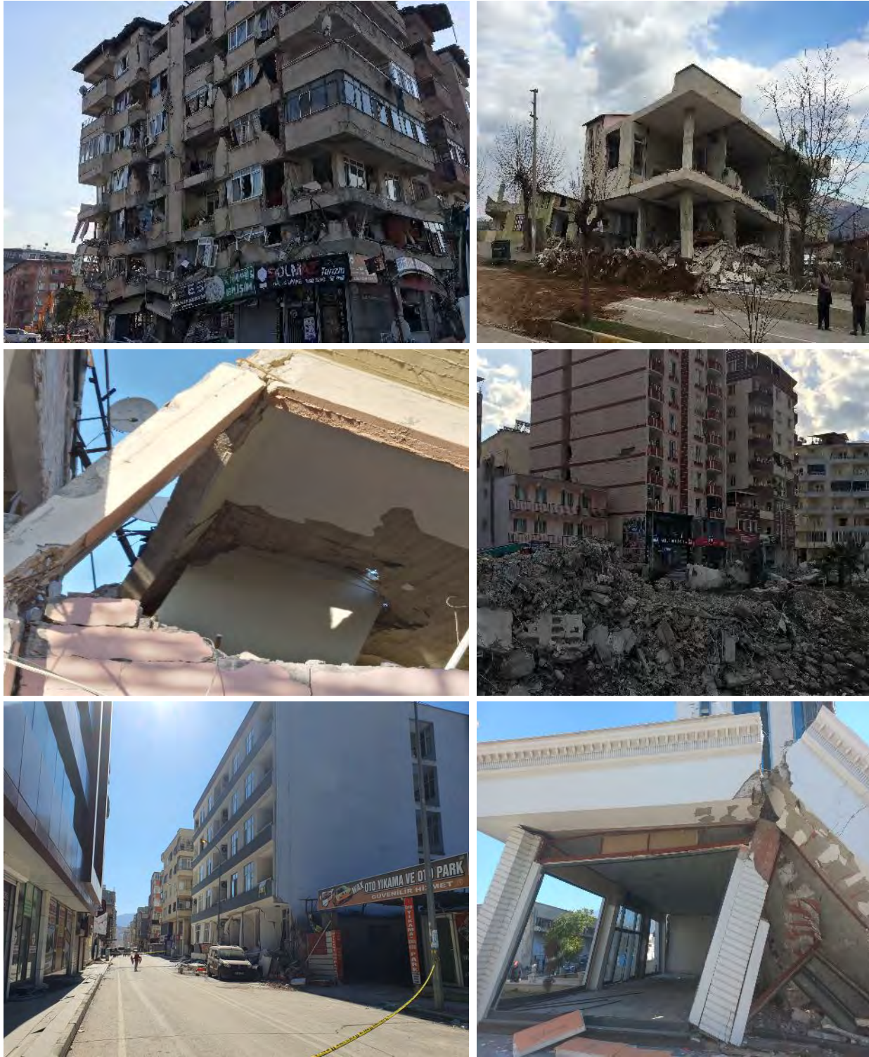
Şekil 67. Yumuşak kat düzensizliği ve ağır çıkmalar sonucunda oluşan hasarlar (devam)
