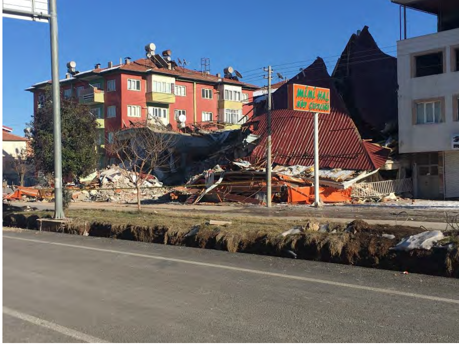
Şekil 18. Aynı zemin koşullarında hasar gören ve görmeyen yapılara örnekler
