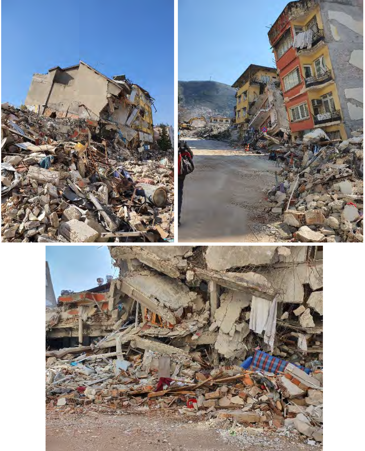
Şekil 66. Hatay ilinde yıkılan betonarme binalar
