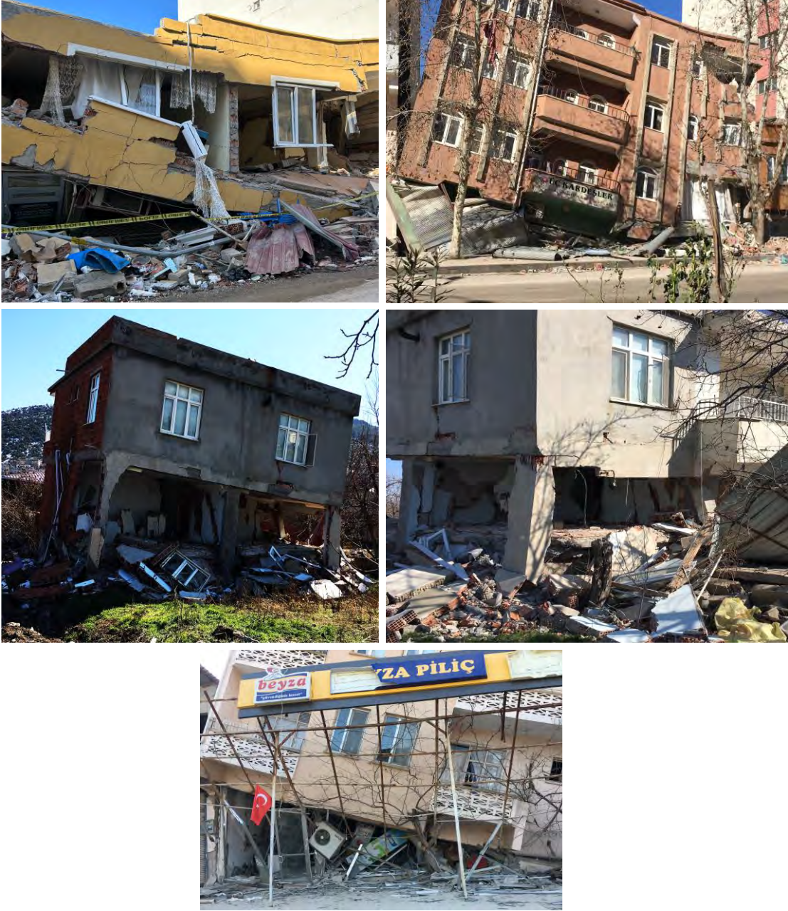
Şekil 88. Kahramanmaraş'ta gözlemlenen zayıf kat yıkılmasına bağlı çökme örnekleri
