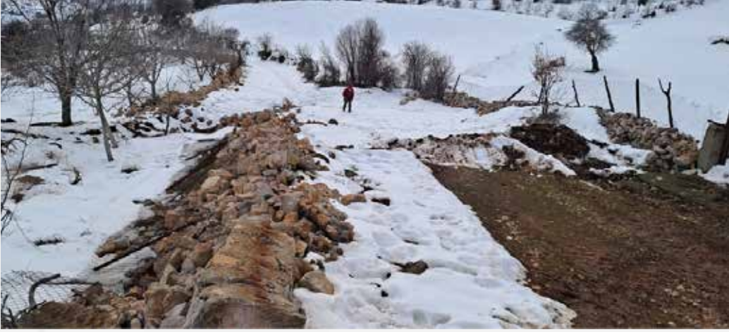
Şekil 1.33. Gözpinar doğusunda ~6 m sol-yanal ötelenmiş taş duvar (Enlem: 38^{\circ} 1' 2,503'' N; Boylam: 37^{\circ} 15' 21,726'' E; Yükseklik: 1.390 m.)
