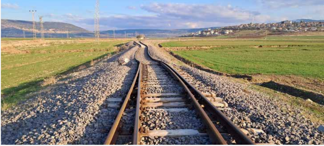
Şekil 1.24. Narlı kuzeyinde 70 m.lik bir zon içinde 5 kırık halinde görülen deformasyon. Toplam yer değiştirme 240±20 cm olarak ölçülmüştür
