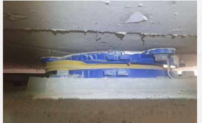
Şekil 3.68. Sismik izolasyonlu Adıyaman EAH binası
