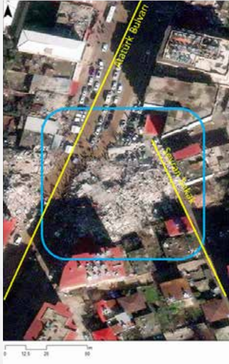
Şekil 3.5a. Gaziantep- İslahiye uydu görüntüsünden kapanan yol örneği
