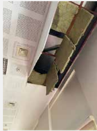
Şekil 3.50. Asma tavan ve bölme duvar hasarları
