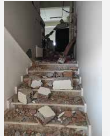
Şekil 3.50. Asma tavan ve bölme duvar hasarları
