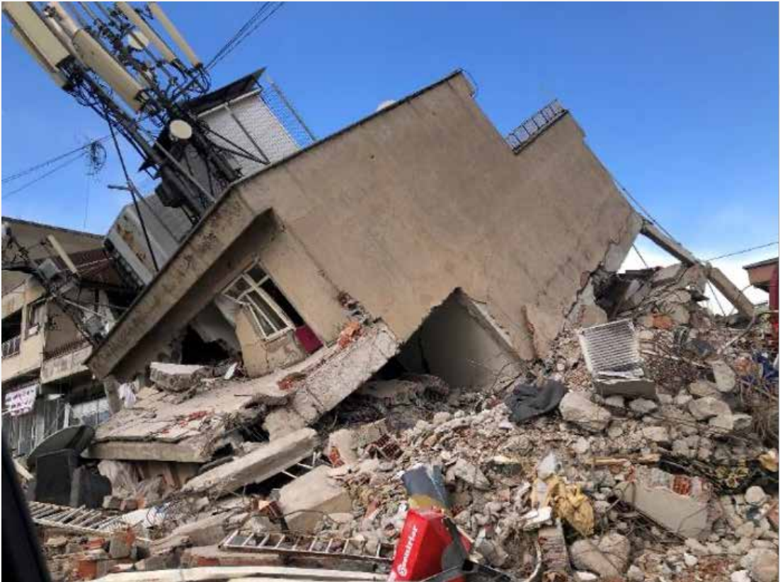
Şekil 3.81. Yıkılan bir binada bulunan baz istasyonundan görünüm
