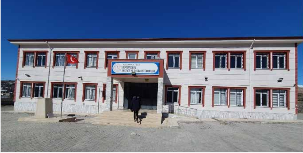
Şekil 3.67. Boyundere Hatice Yıldırım Ortaokul binası
