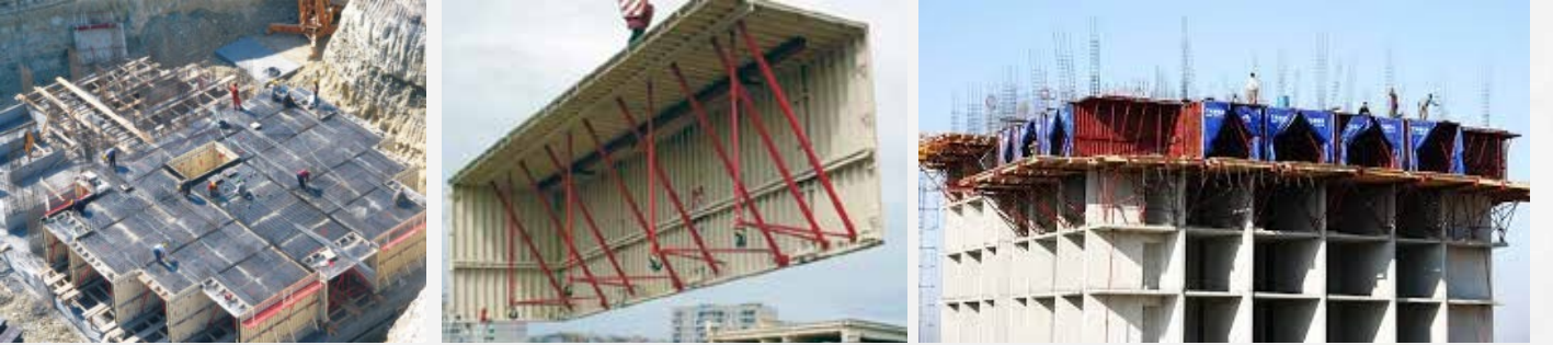
Şekil 4.3. Tünel kalıp sistem ile bina inşaatı
