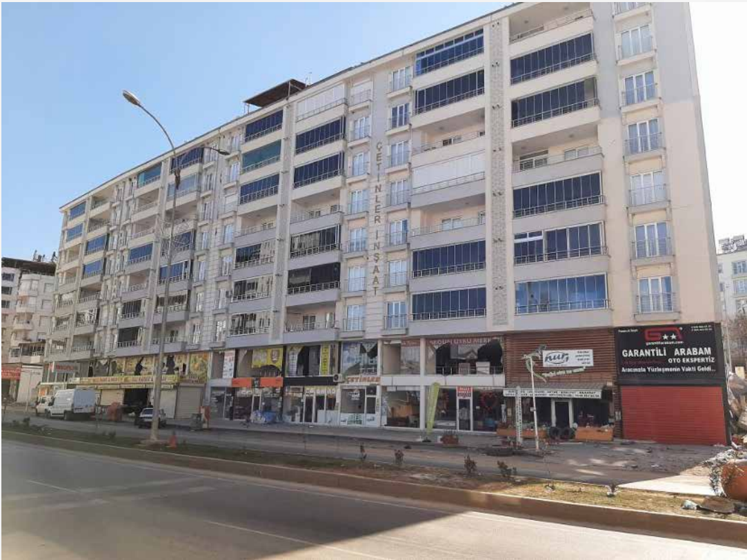
Resim 11. Pazarlık İlçesi D360 karayolu üzerinde bulunan yüksek giriş katı olan ve üzerinde 7 normal katı bulunan betonarme binalar
