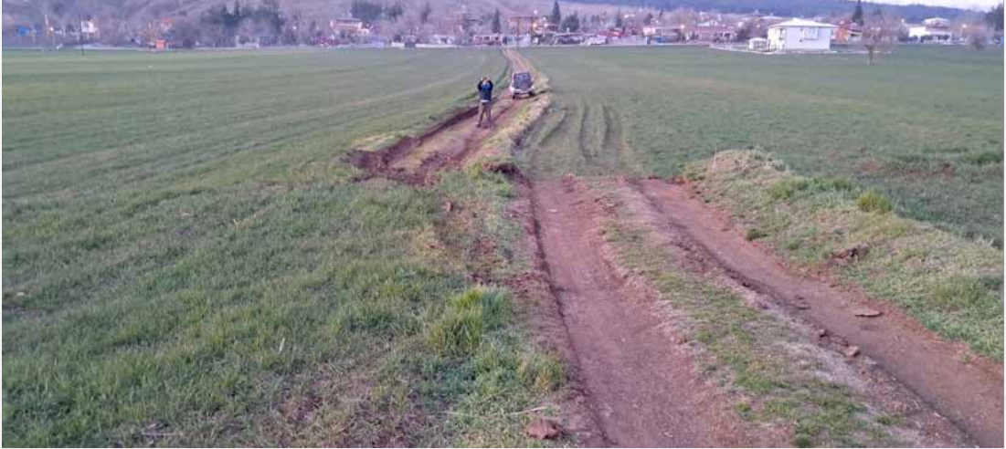
Şekil 1.18. Kapıçam doğusunda 460±20 cm yol ötelenmesi (Enlem: 37° 27' 57,066" N; Boylam: 37° 0' 55,36" E; Yükseklik: 595 m.)
