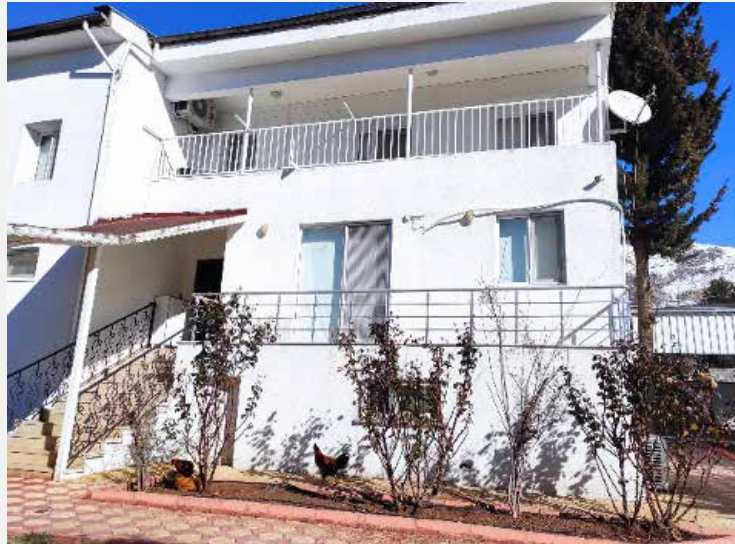
Şekil 4.60. Kaymakamlık Lojmanı binasının genel görünüşü
