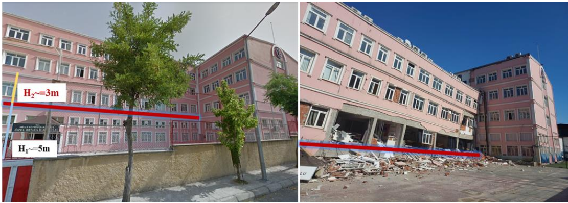
Şekil 5.4. Birinci katında asma kat olduğu tahmin edilen bir okul binası
