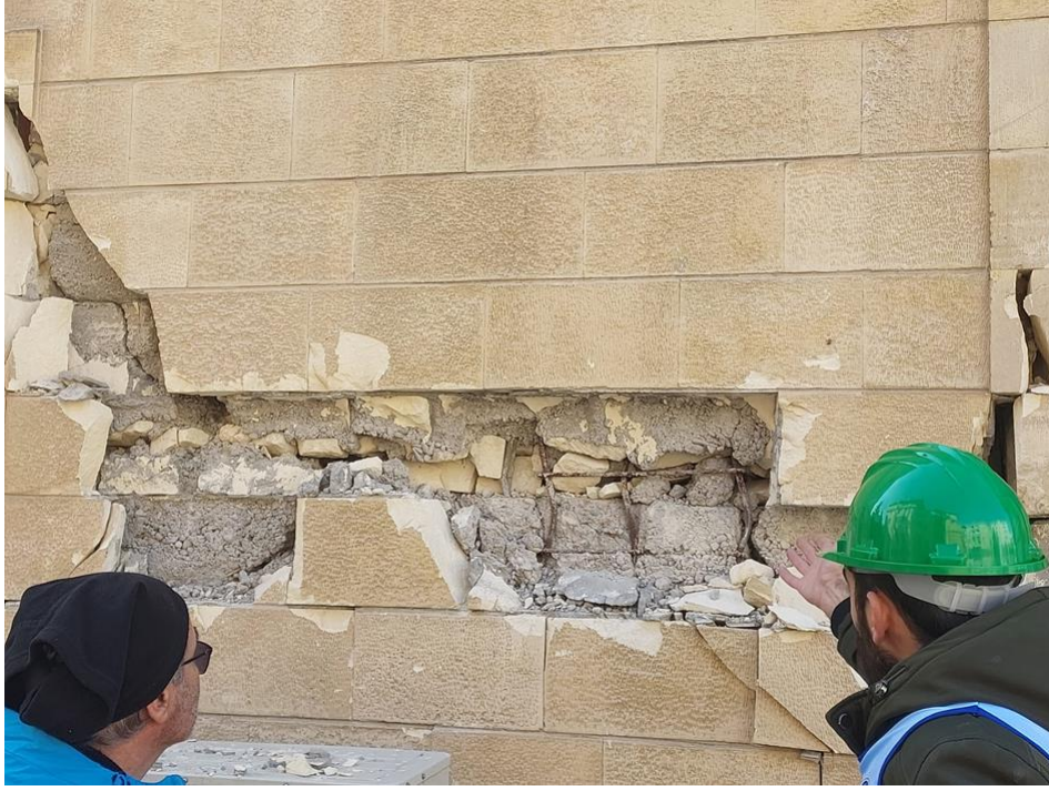
Şekil 5.14. Beton yerine farklı malzemeler yerleştirilerek oluşturulmuş cami duvarı
