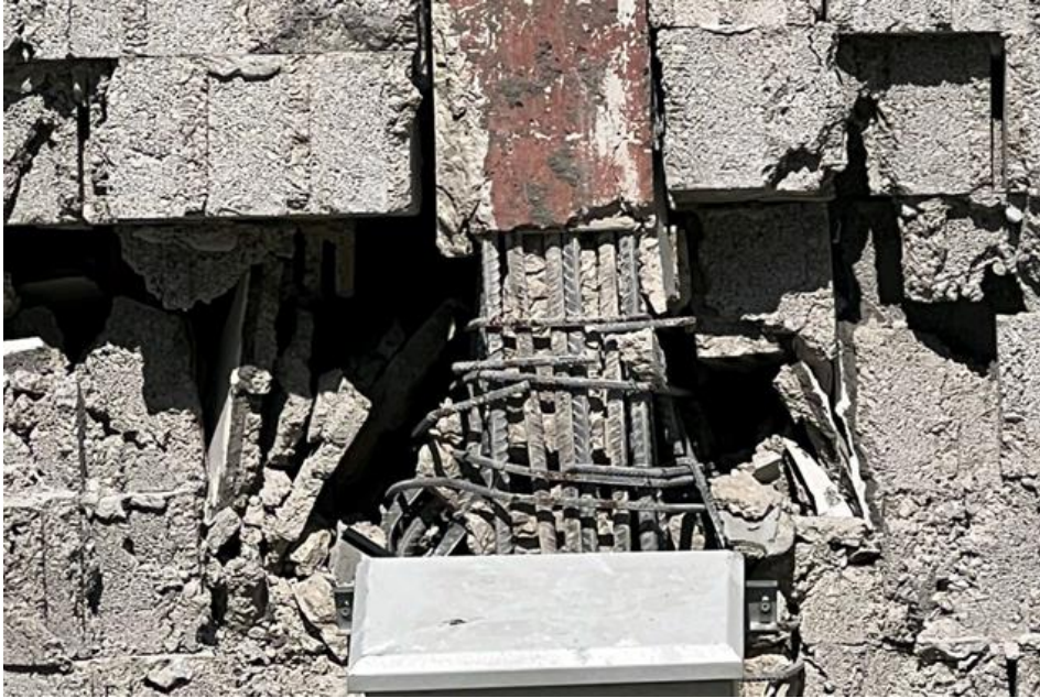
Şekil 5.10. Uçları 135° derece bükülmemiş olması nedeniyle açılan etriye donatıları
