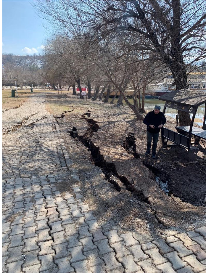
Şekil 4.21. Yanal yayılma sebepli yüzey deformasyonları
