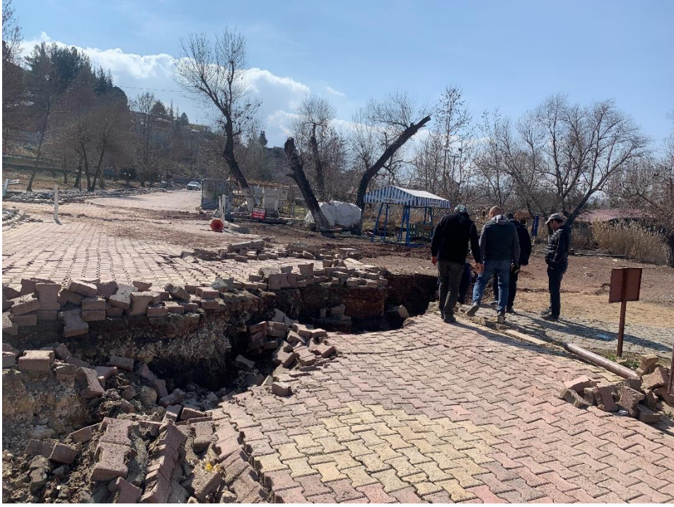
Şekil 4.20. Gölbaşı ilçesinde göl kıyısında gözlenen yüzey deformasyonları
