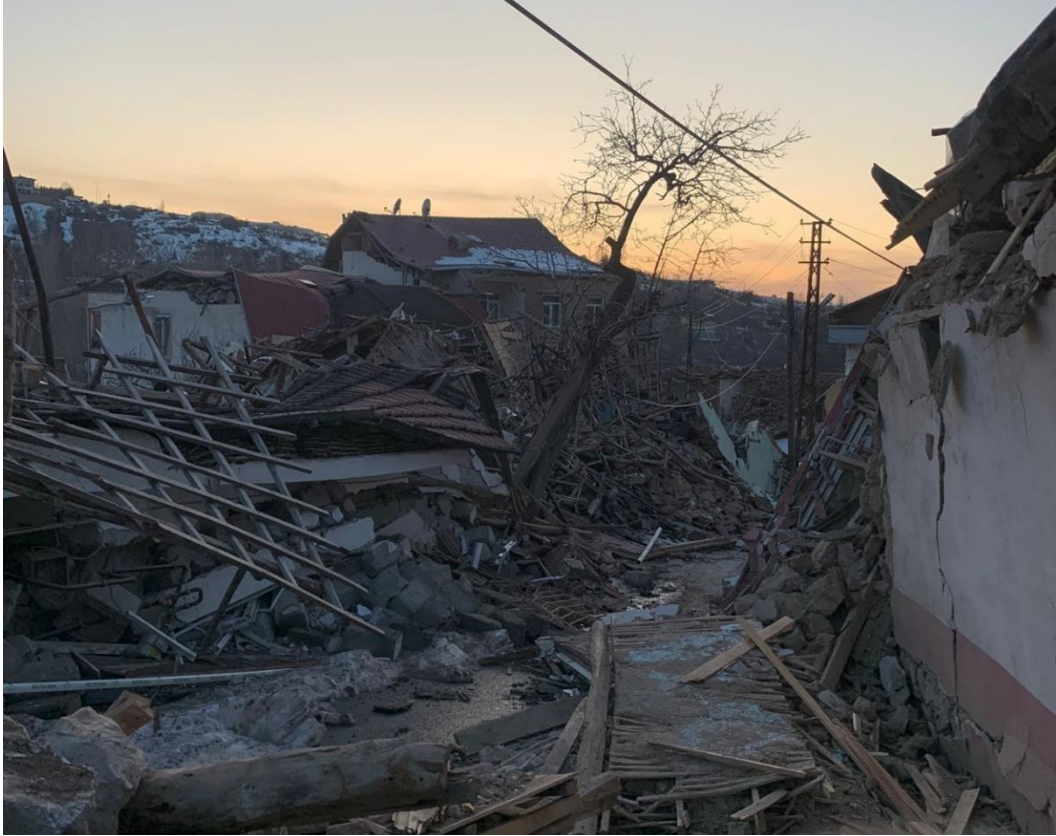
Şekil 5.28. Geleneksel kerpiç yapı hasarları
