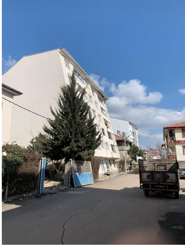
Şekil 4.10. Gölbaşı ilçesinde bir yapıda gözlenen taşıma gücü kaybı ve deformasyonlar
