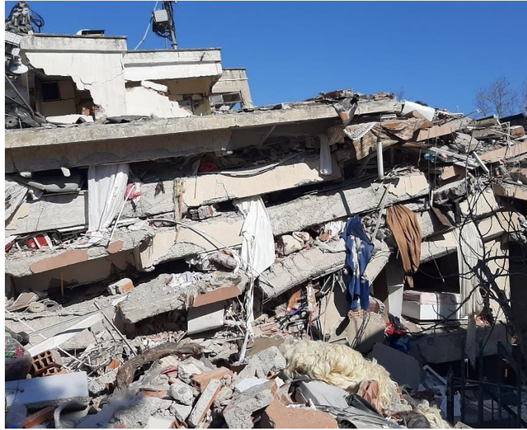
Şekil 5.8. Kolonların Kirişlerden daha güçlü olması koşulunun sağlanmadığı bir göçük
