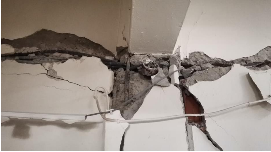
Şekil 5.13. Elektrik kablosu ve buat yerleştirmek için kırılmış kolon kiriş birleşim yeri
