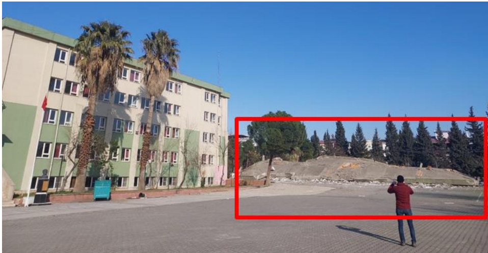
Şekil 5.18. Güçlendirilmiş okul binası ve güçlendirilmemiş okul binası
