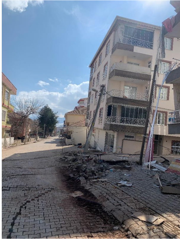
Şekil 4.9. Gölbaşı ilçesinde radye temel üzerindeki yapıda gözlenen deformasyonlar
