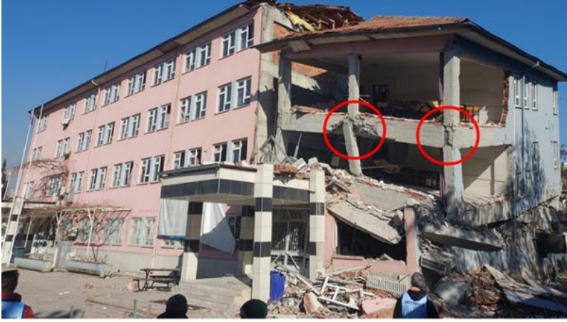
Şekil 5.9. Kötü donatı detaylandırması ve birleşim bölgesinde etriye yetersizliği
