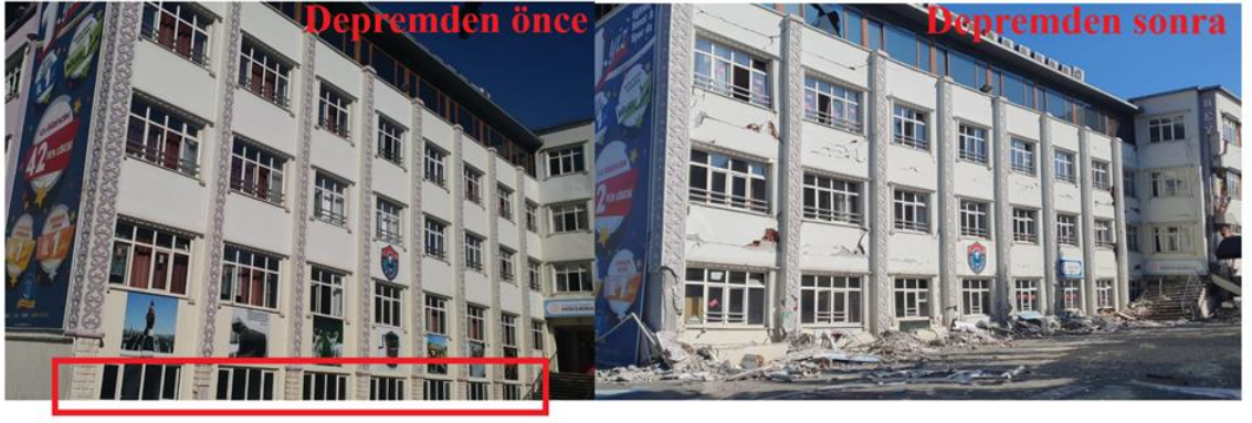
Şekil 5.5. Kısa kolona sahip bir okul binasının depremden önce ve sonraki görüntüsü
