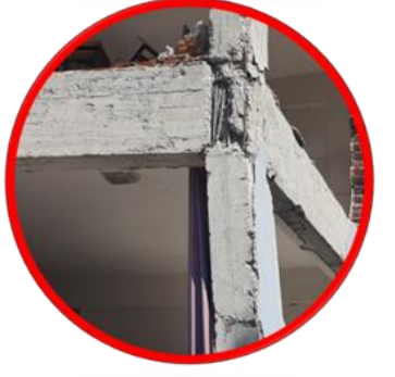
Şekil 5.9. Kötü donatı detaylandırması ve birleşim bölgesinde etriye yetersizliği
