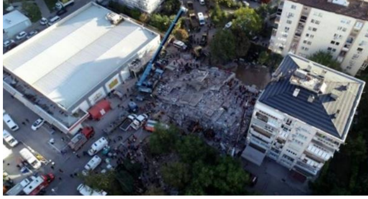
Şekil 4.3. Tamamen yıkılan Doğanlar Apartmanı
