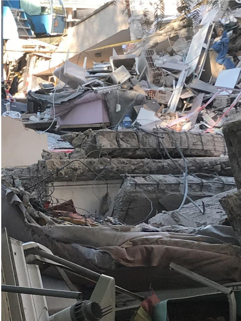
Şekil 5.3 : Z+7 Katlı Doğanlar Apt., Etriye sıklaştırma bölgesinin bulunmaması ve enine donatı uçlarının 135 derece bükülmemesi
