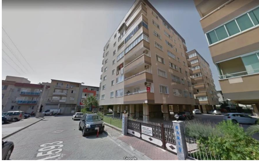
Şekil 4.32 : Z+7 Katlı Binalardan oluşan Barış Sitesi deprem öncesi görüntüsü (www.google.com)
