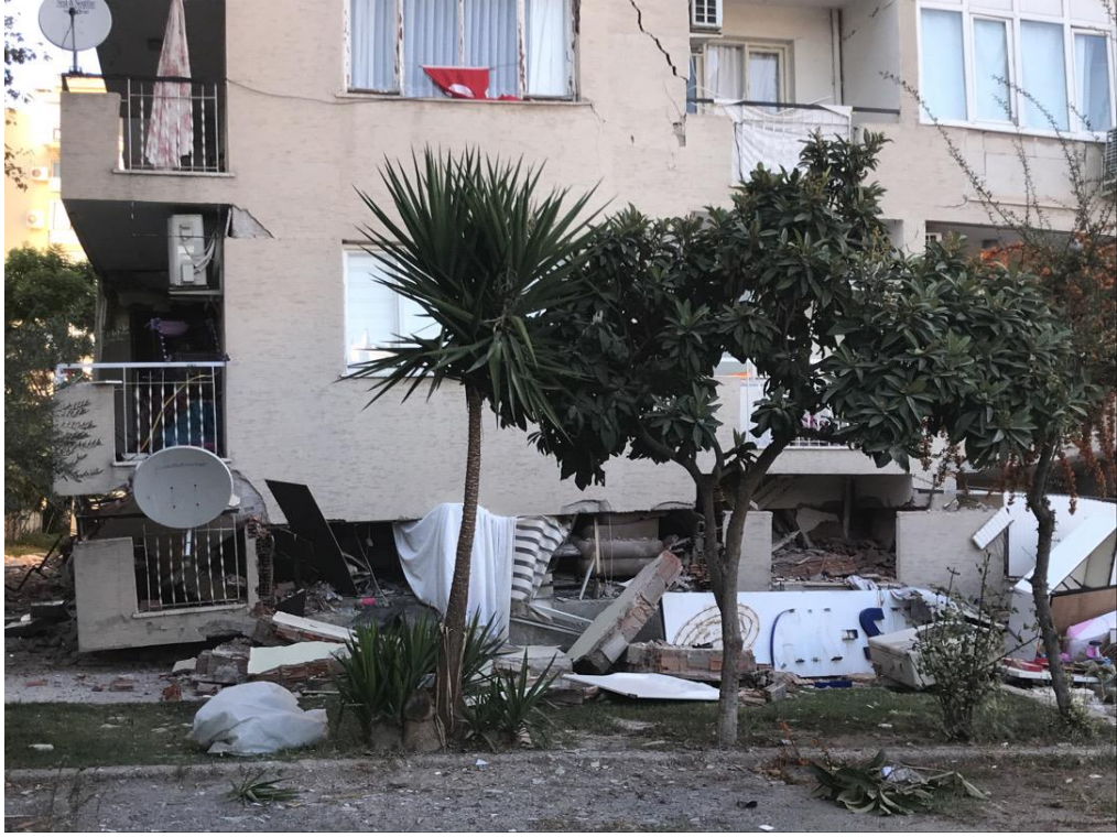
Şekil 4.27 : Zemin+6 katlı Egemen Apt
