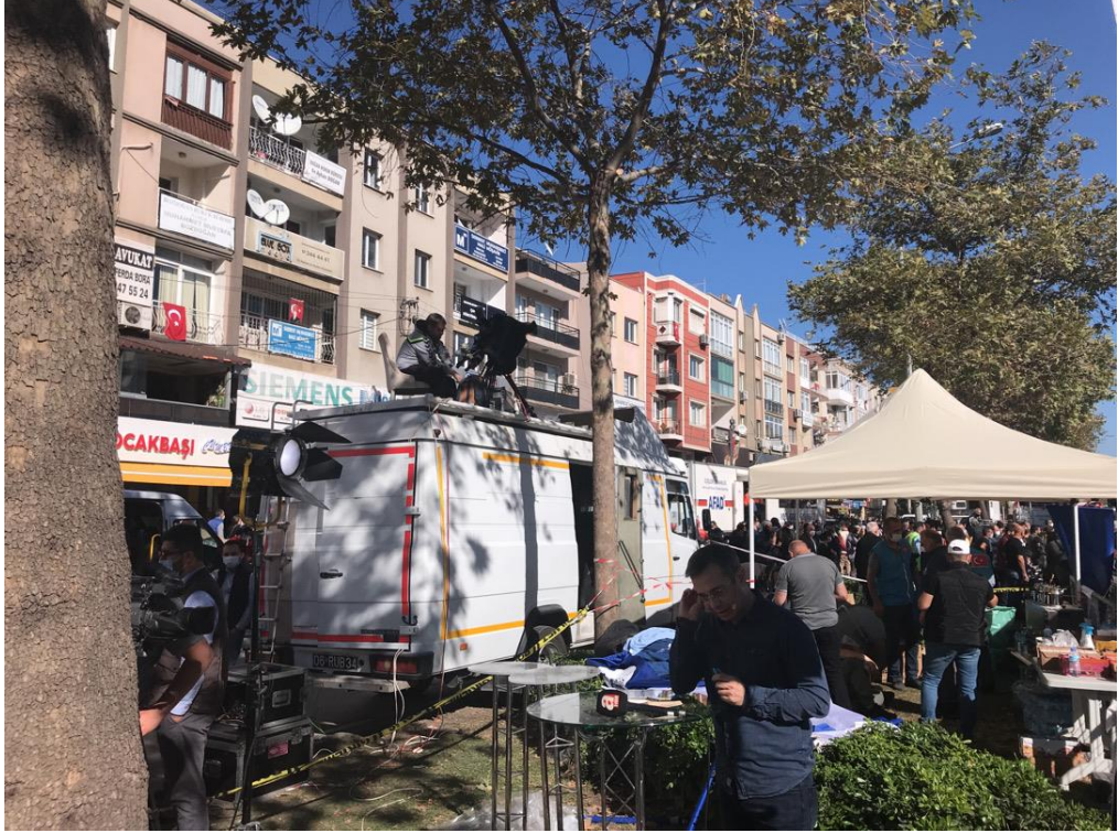
Şekil 4.6 : Rızabey Apt. karşı cephesinde kullanıma devam edilen Zemin+4 kat binalar,
