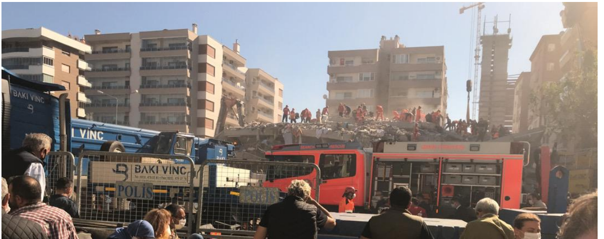
Şekil 4.3 : Rızabey Apt. Deprem sonrası fotoğrafı
