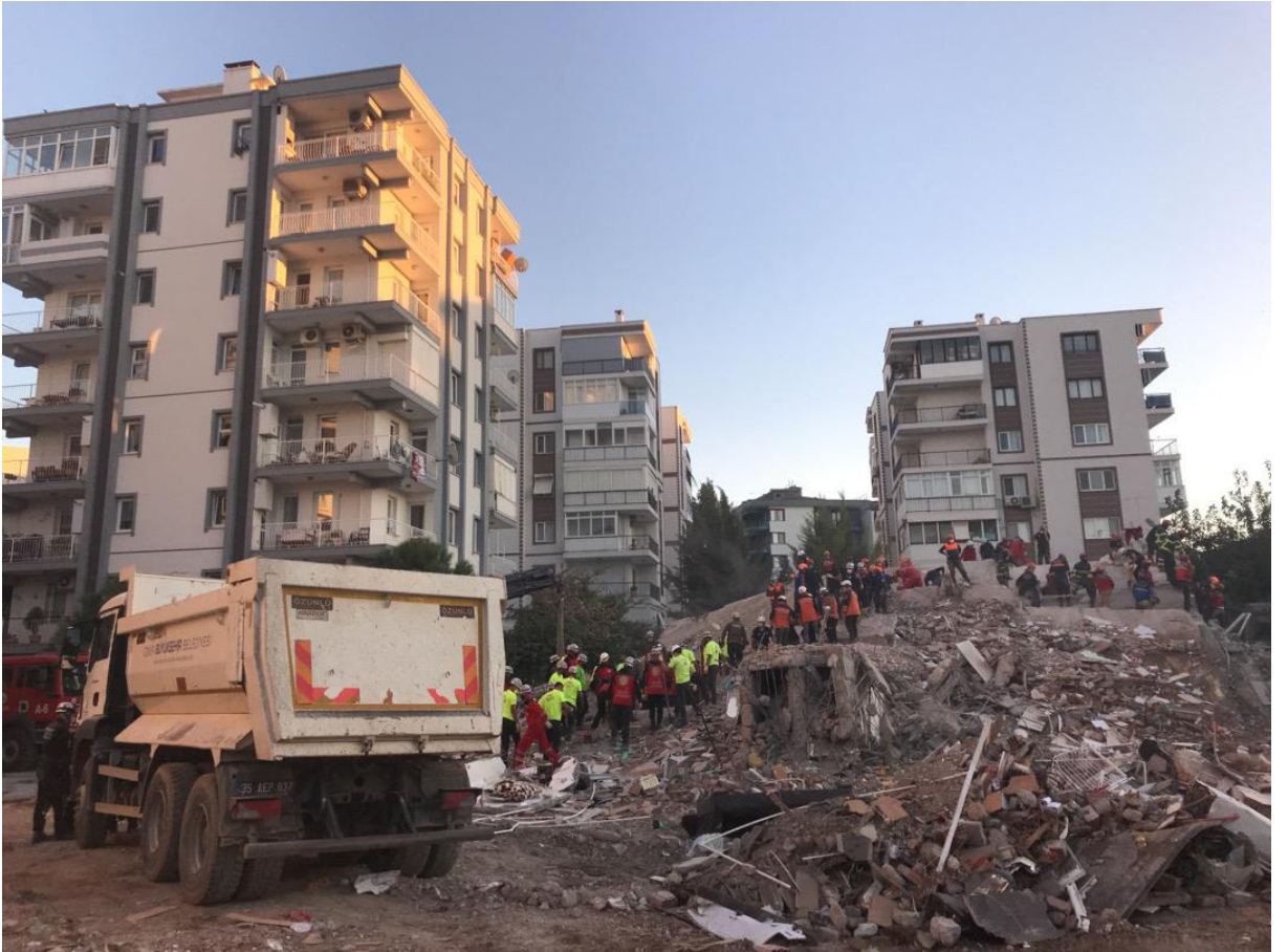
Şekil 4.22 : Zemin+7 katlı Yağcıoğlu Sitesi, Stabilitesini koruyan blok solda
