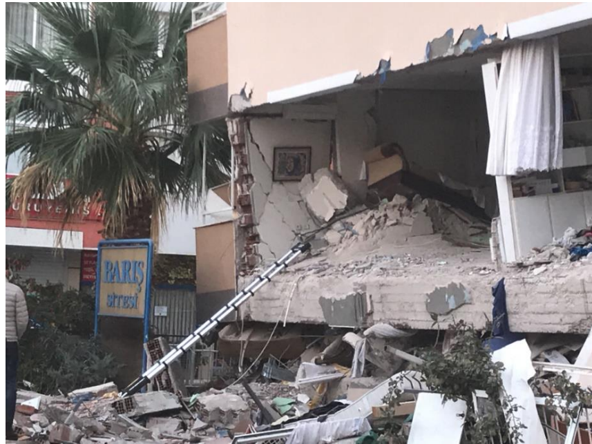
Şekil 4.33 : Z+7 Katlı Binalardan oluşan Barış Sitesi, zemin kat kolonlarında göçme
