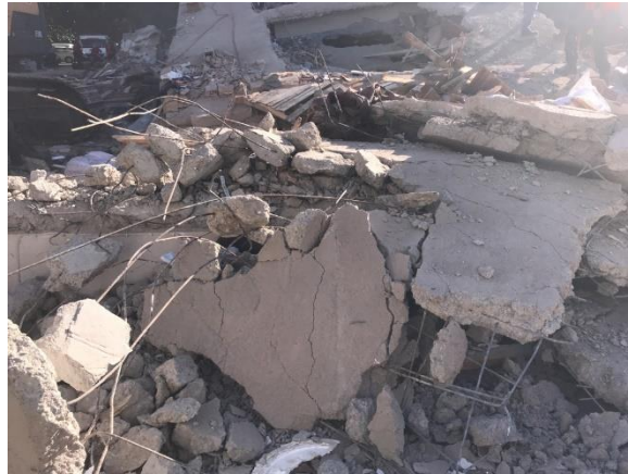
Şekil 5.11 : Kalitesiz beton
