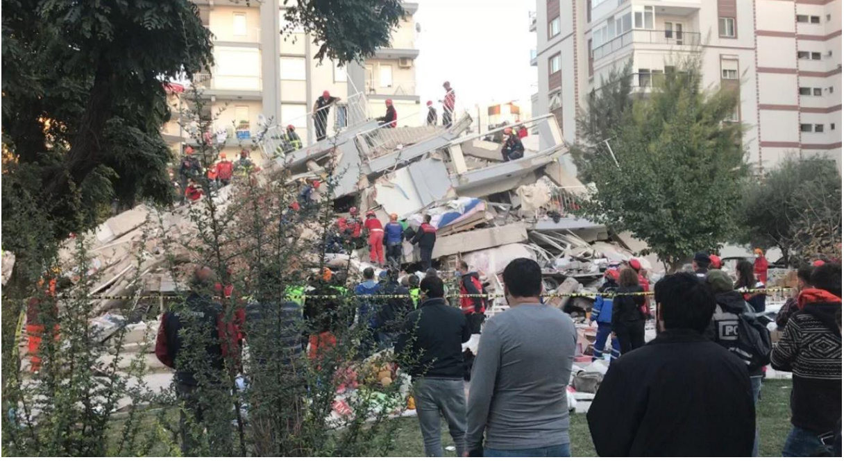
Şekil 4.21 : Zemin+7 katlı Yağcıoğlu Sitesi, Stabilitesini koruyan blok arkada solda
