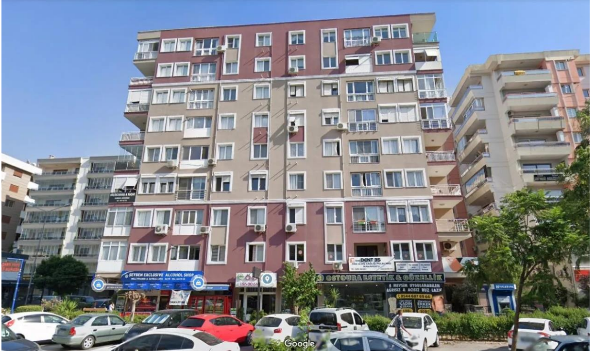
Şekil 4.2 : Rızabey Apt. Deprem öncesi fotoğrafı
