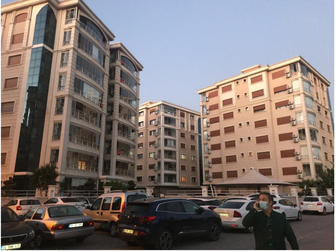
Şekil 4.40 : Barış Sitesi ve Cumhuriyet Stesi civarında yer alan ve dış cephelerinde hasar gözlemlenmeyen Z+7 Katlı Yapılar
