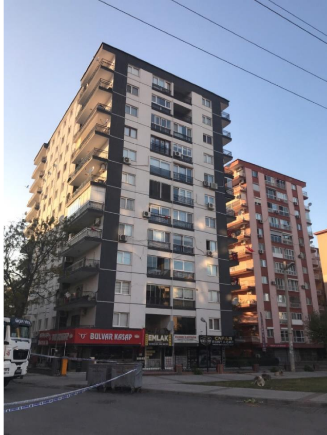
Şekil 4.31 : Yılmaz Erbek Apt. civarındaki Z+11 Katlı Bina, yapı stabilitesini korumaktadır.
