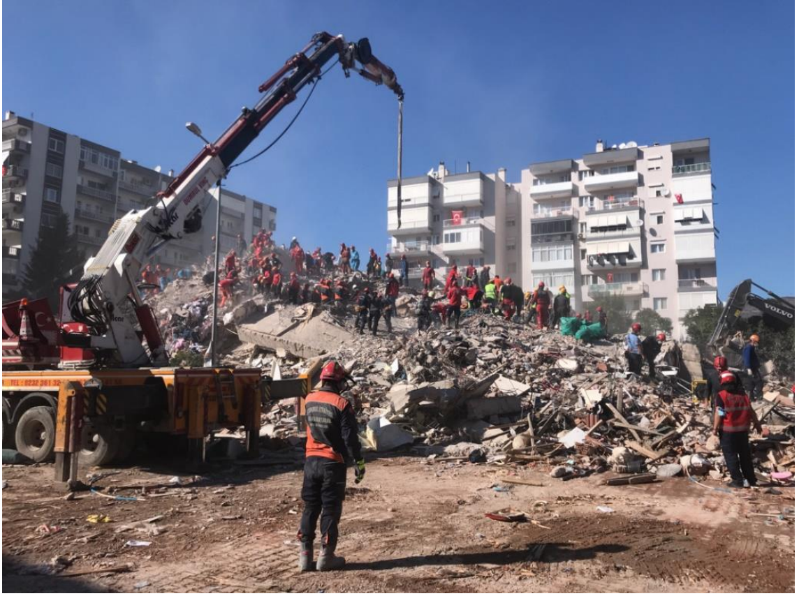
Şekil 4.17 : Zemin+7 katlı Emrah Apt., Deprem sonrası
