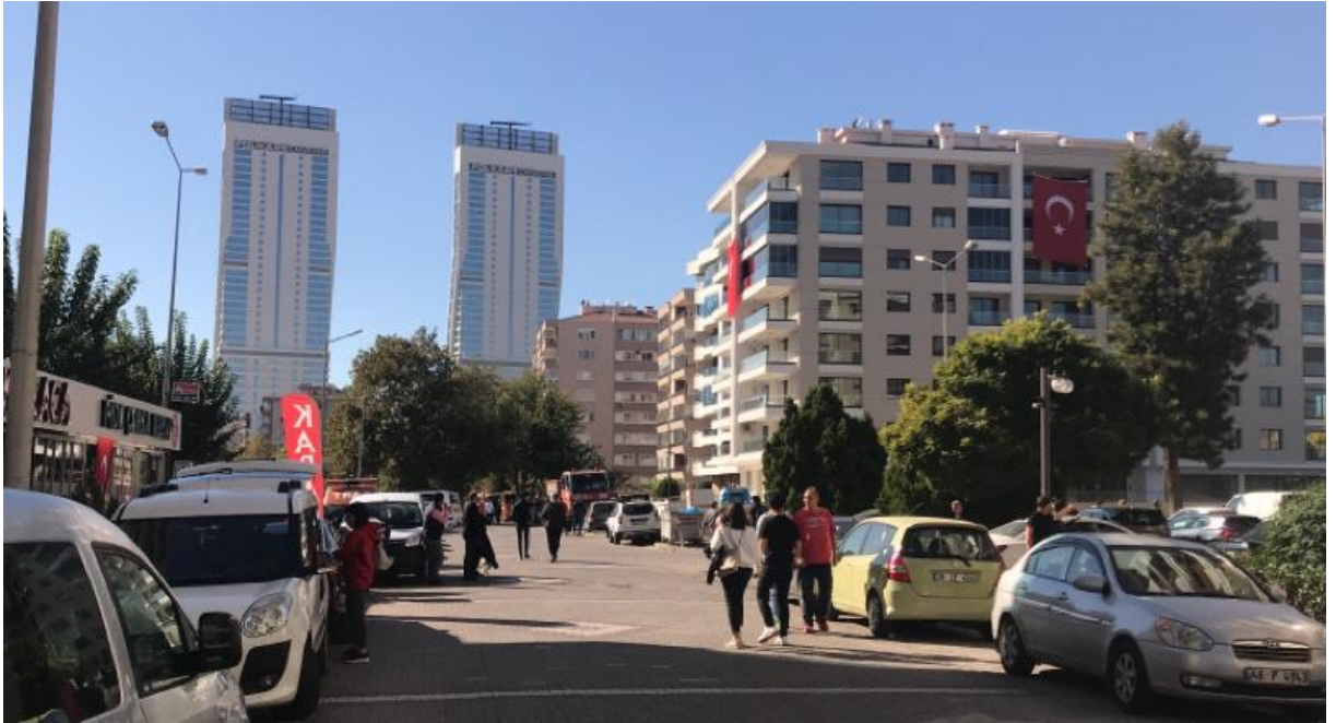
Şekil 4.9 : Rızabey Apt. civarında göçmeyen ve dış cephede hasar gözlemlenmeyen binalar
