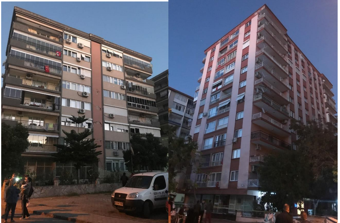
Şekil 4.41 : Barış Sitesi ve Cumhuriyet Sitesi civarındaki dış cephede hasar gözlemlenmeyen Z+7 ve zemin+11 katlı yapılar
