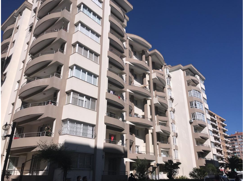
Şekil 4.7 : Rızabey Apt. civarında göçmeyen ve dış cephede hasar gözlemlenmeyen binalar
