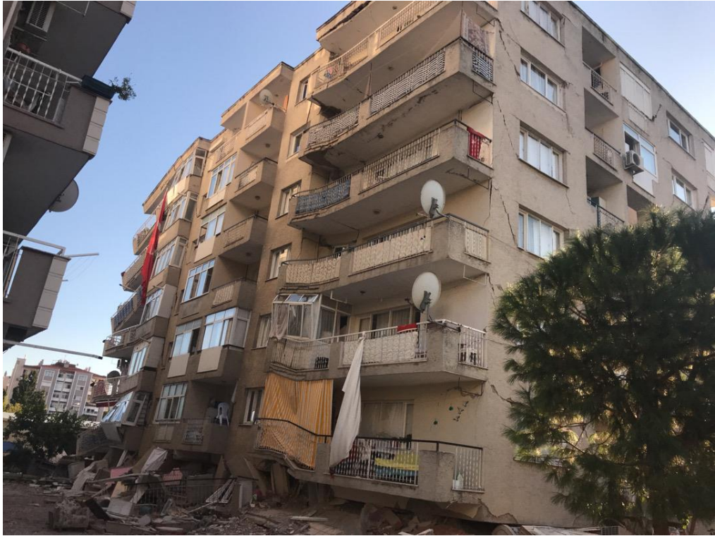
Şekil 4.28 : Zemin+6 katlı Egemen Apt
