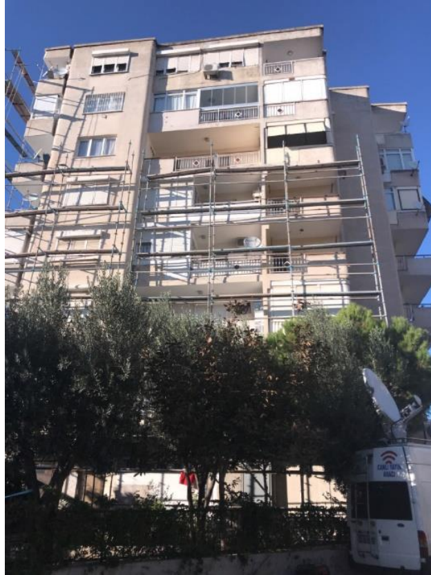
Şekil 4.15 : Doğanlar Apt. civarında deprem sonrası stabilitesini koruyan Z+8 Katlı bir yapı
