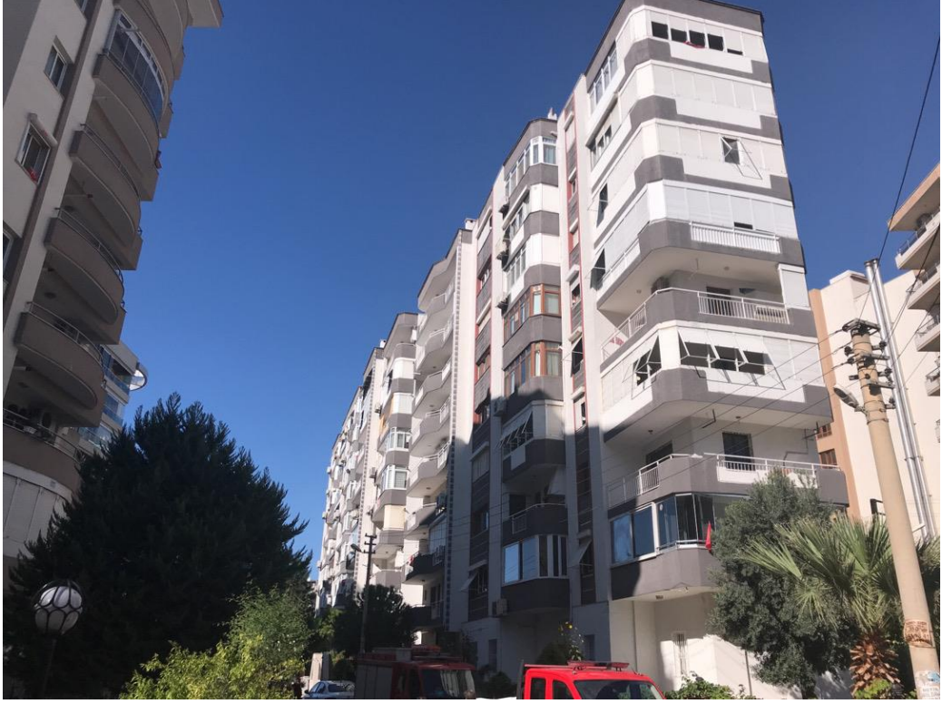
Şekil 4.4 : Rızabey Apt. civarında, göçmeyen ve dış cephede hasar gözlemlenmeyen binalar
