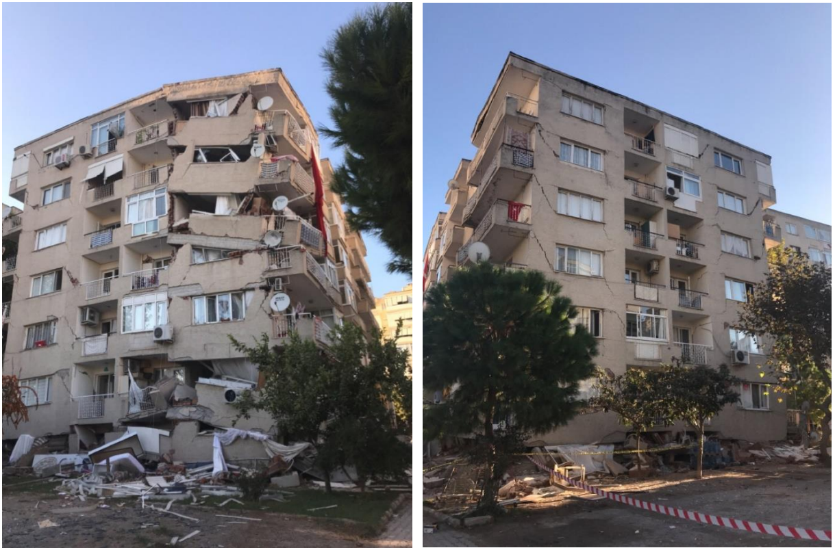
Şekil 4.26 : Zemin+6 katlı Egemen Apt
