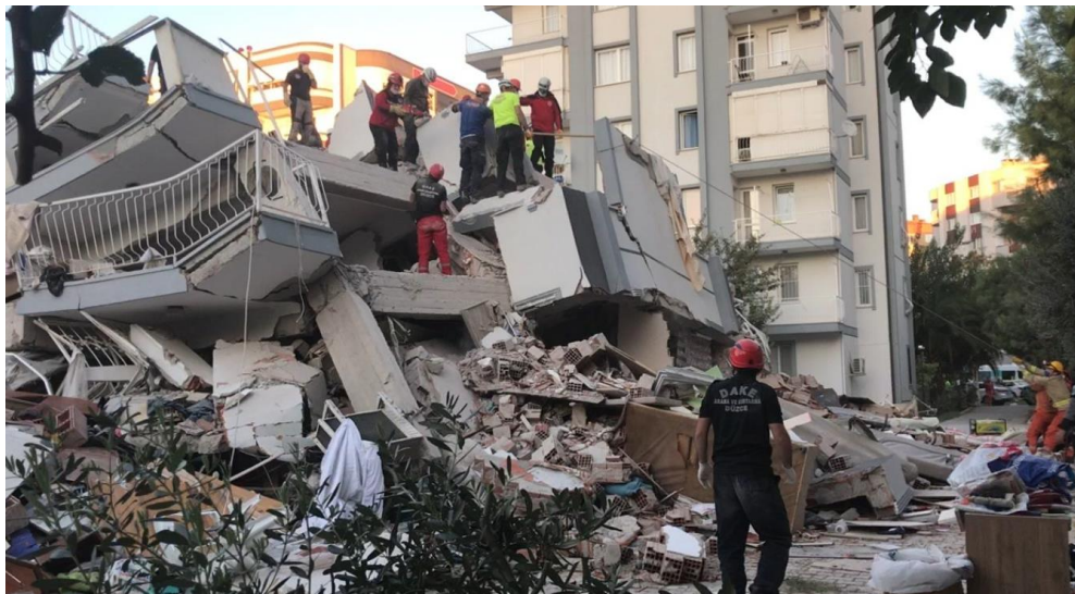
Şekil 4.20 : Zemin+7 katlı Yağcıoğlu Sitesi A ve B Blok (Bina deprem öncesi fotoğraf ile sonrası arasındaki renk farkı binanın sonradan dış cephesinin boyandığına işaret etmektedir.)
