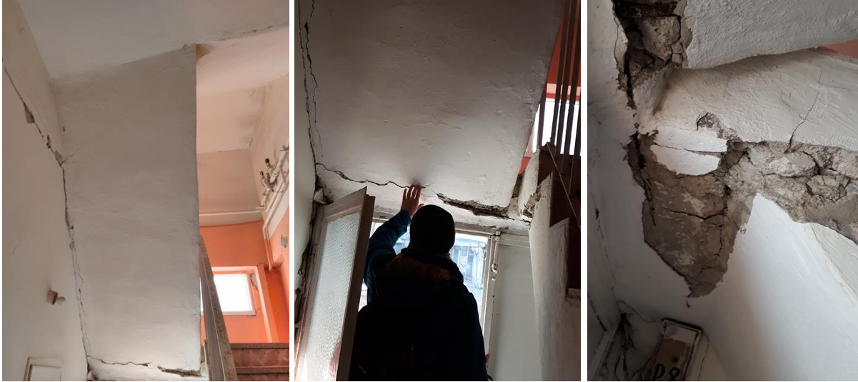
Şekil 40. Gözlemlenen merdiven hasarları
