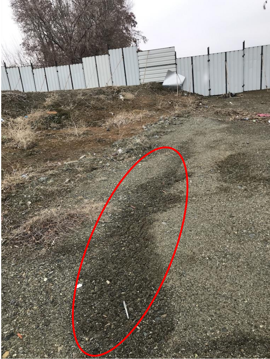
Şekil 11. Sıvılaşmış zemin bantları
