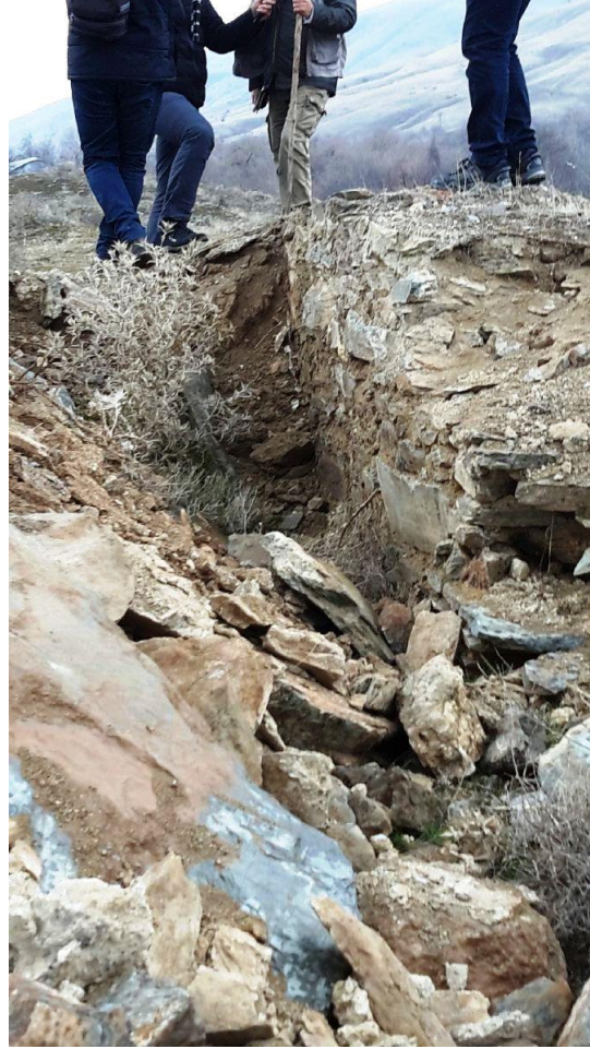
Şekil 33. Fayın muhtemel yüzey kırığının yaratmış olduğu tektonik sıkışmanın etkisiyle tarihsel bina temellerinde meydana gelen açılma ve yükselmeler (bugünkü hasar durumu tasvir eden tipik bir örnek)
