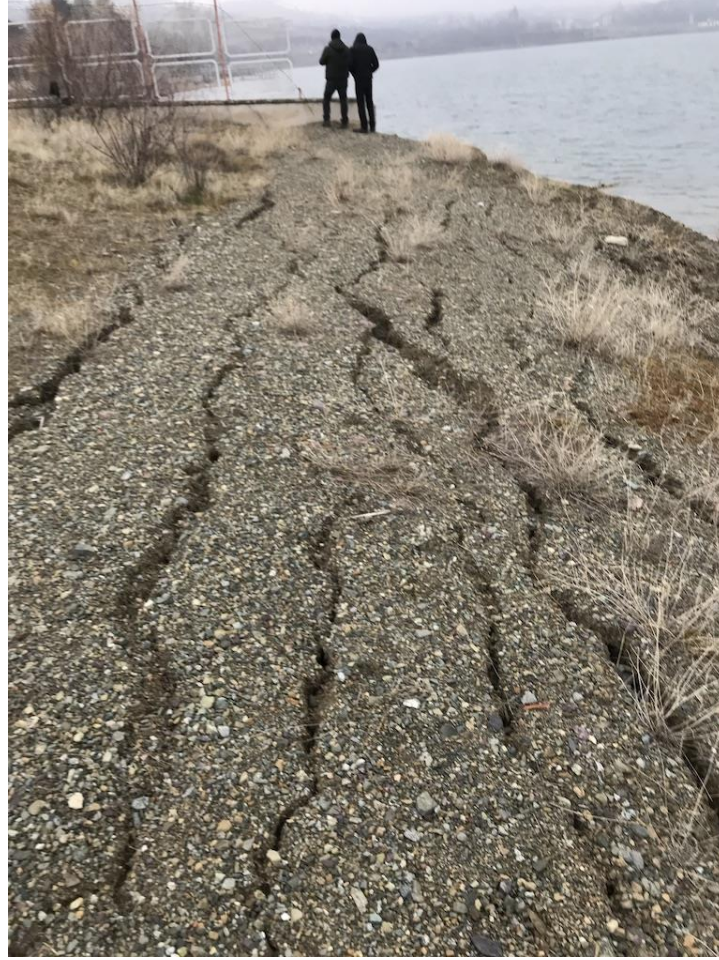
Şekil 8. Ardışık zemin çatlakları
