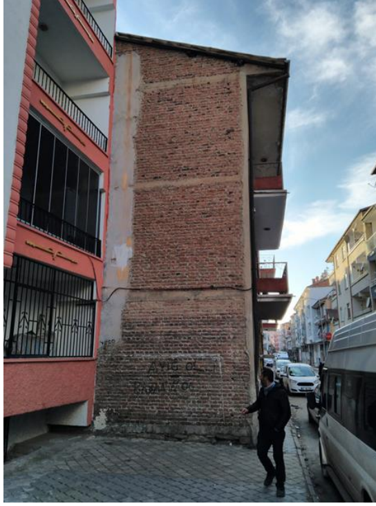
Şekil 45. Elazığ şehir merkezindeki yığma binaların hasar durumları
