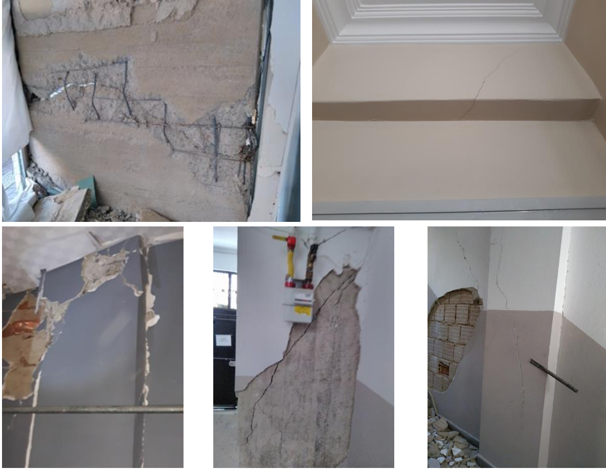
Şekil 41. Gözlemlenen kesme hasarları
