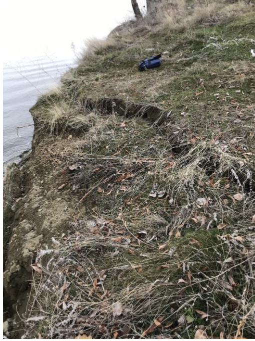
Şekil 16. Bölgede oluşan yanıl deformasyon ve oturmalar
