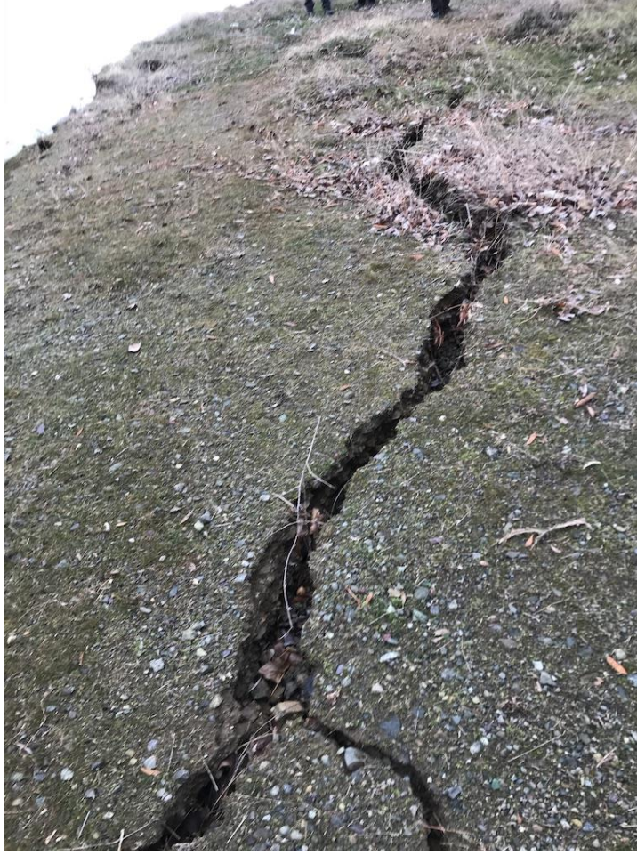
Şekil 19. Yüzey çatlakları ve yanal deformasyonlar
