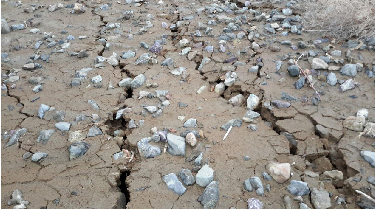
Şekil 22. Ardışık yüzey çatlakları ve ayrışmalar
