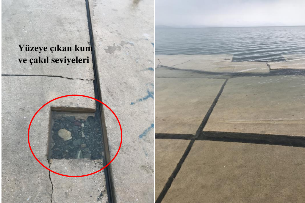
Şekil 7. Sivrice İskelesi beton plakaları
