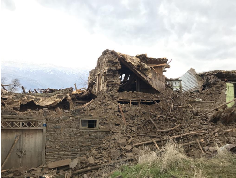
Şekil 29. Deprem etkisi ile yıkılmış binalar
