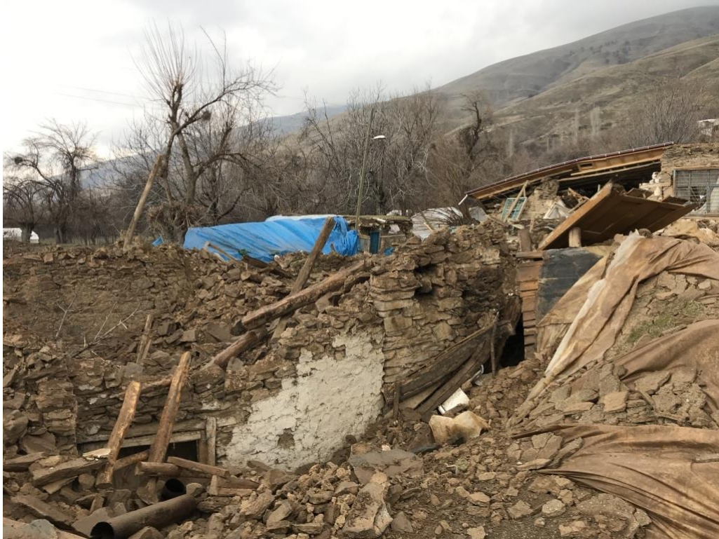
Şekil 27. Deprem etkisi ile yıkılmış binalar
