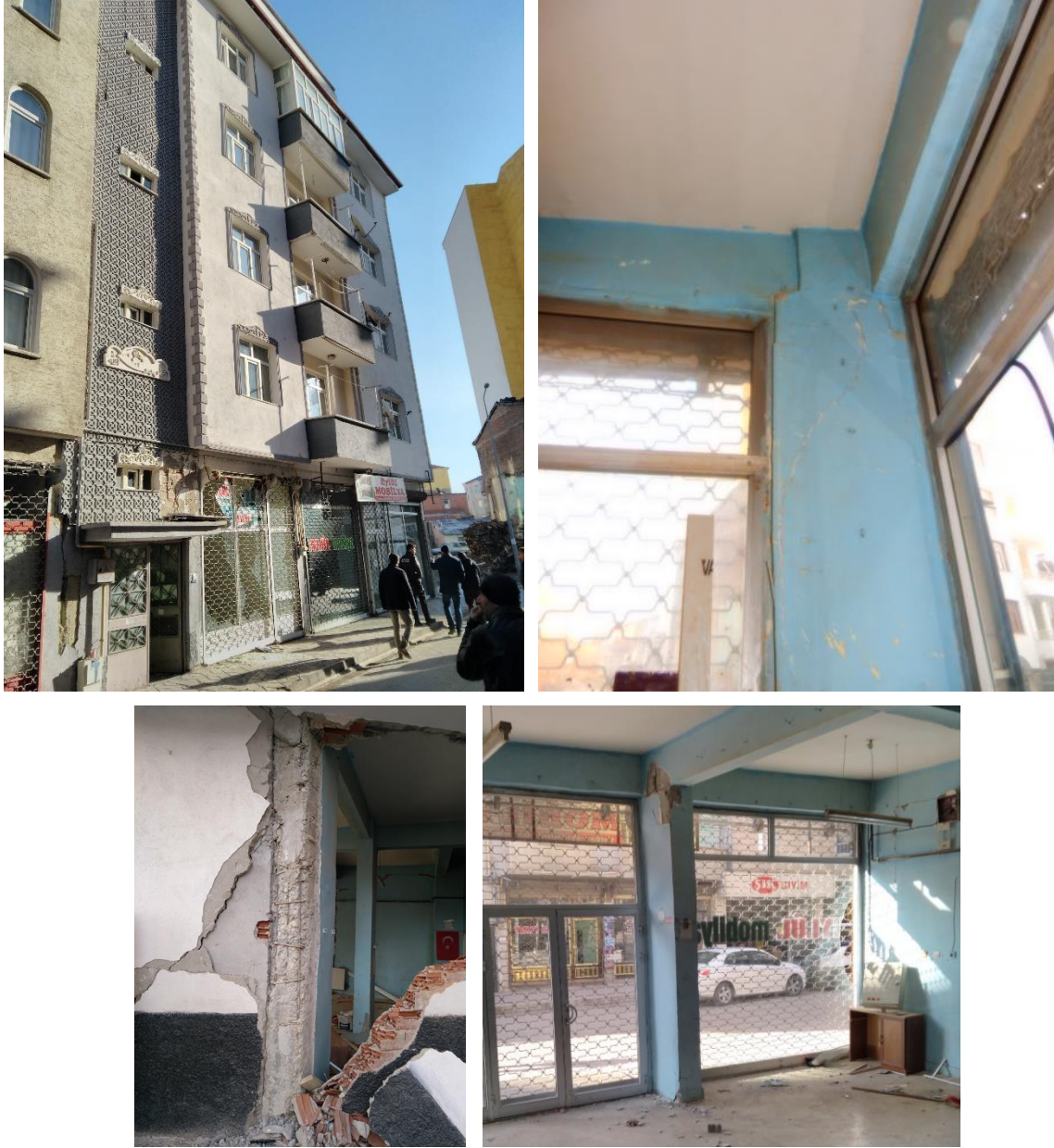
Şekil 37. Yumuşak kat düzensizliği ve sonuçta oluşan hasarlar
