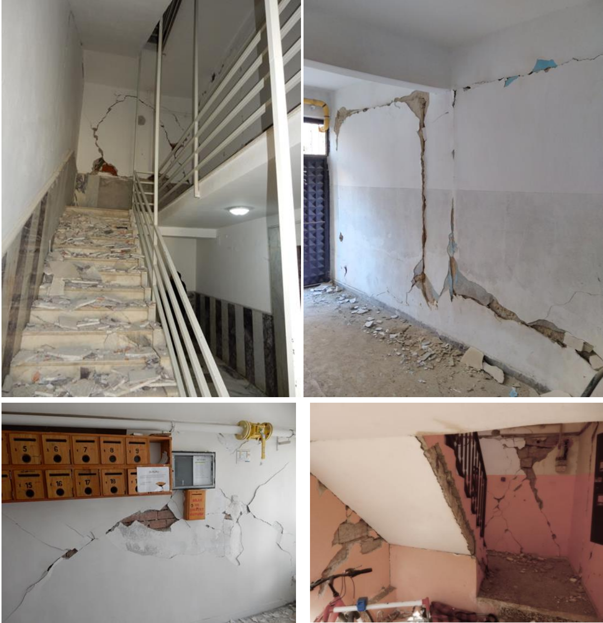
Şekil 43. Yapısal olmayan duvar hasarları 1
