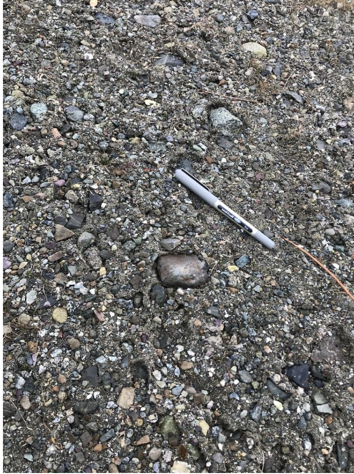
Şekil 12. Sıvılaşmış zemin bantlarına daha yakından bakış
