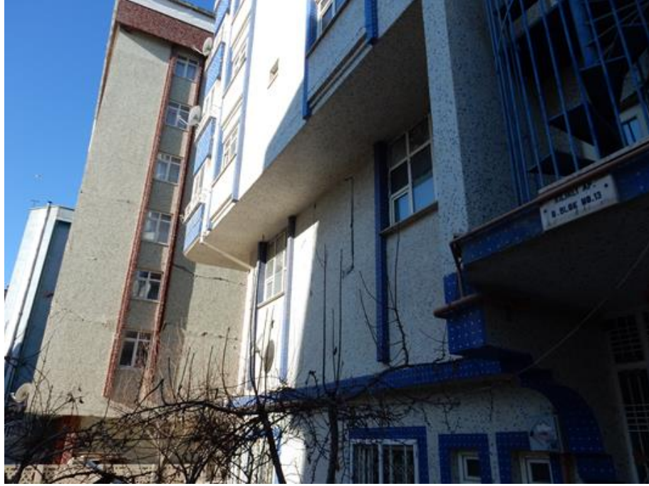
Şekil 42. Ağır çıkmalardan kaynaklı taşıyıcı olmayan duvar hasarları
