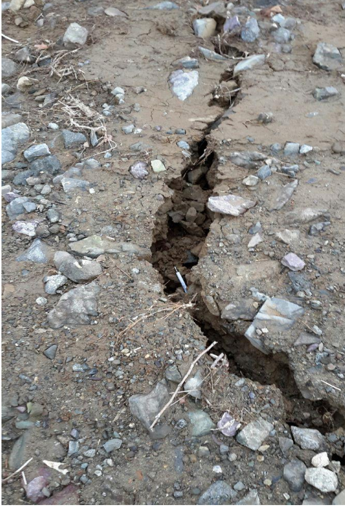
Şekil 21. Yüzey çatlakları ve oturmalar
