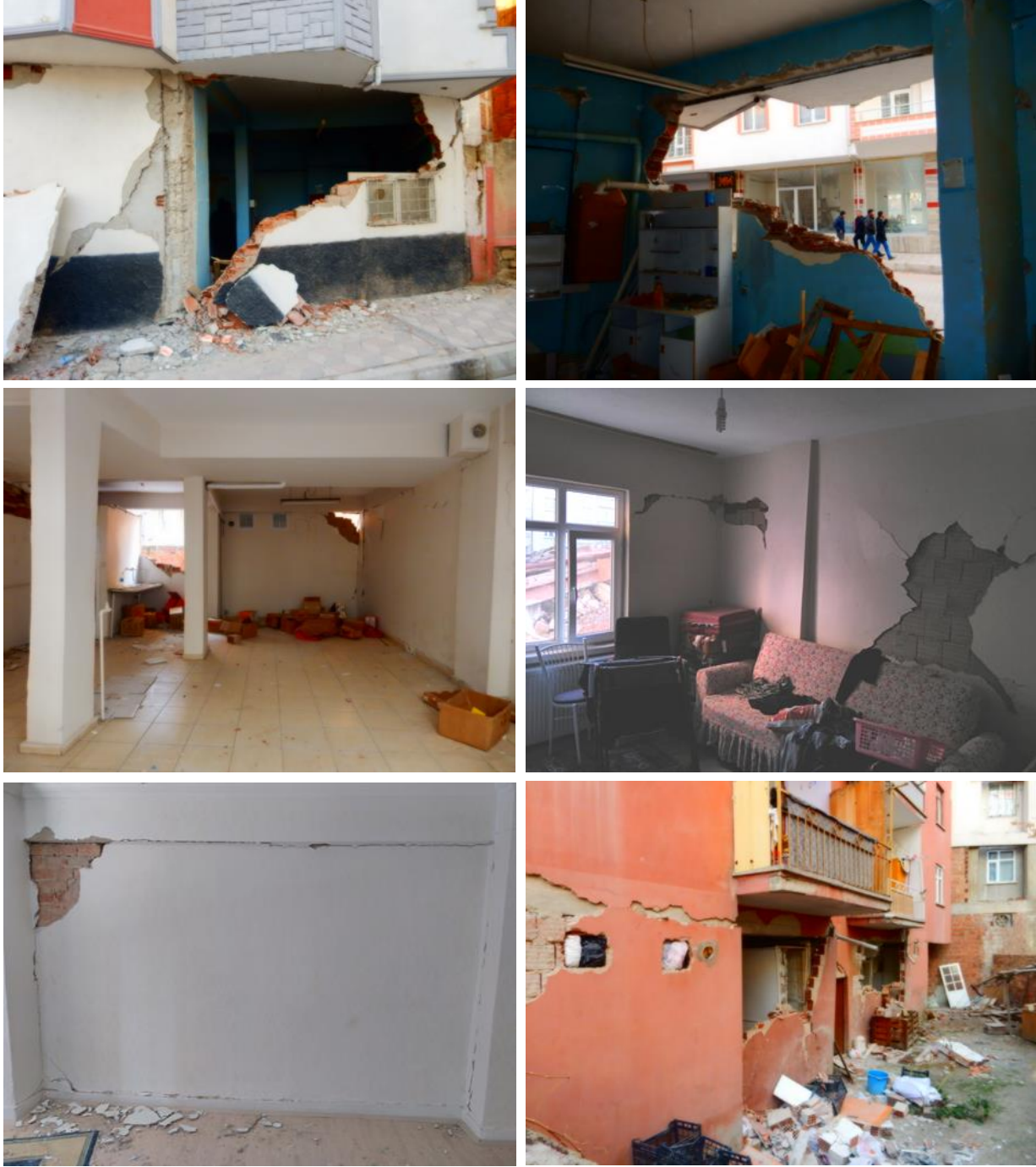
Şekil 44. Yapısal olmayan duvar hasarları 2
