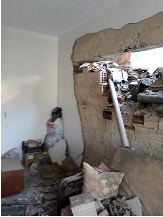
Şekil 38. Binalar arasındaki yetersiz derz boşlukları nedeniyle oluşan bölme duvar ve kolon hasarı
