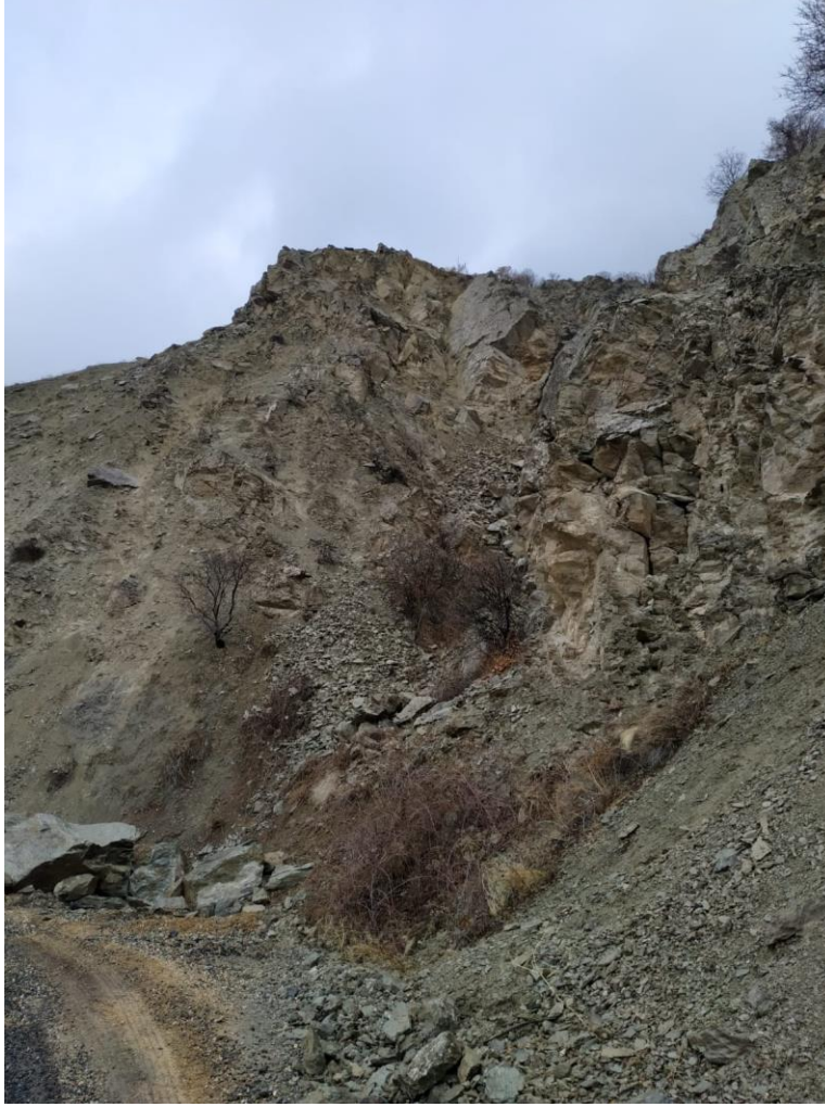
Şekil 35. Sivrice-Çevrimtaş arasındaki köy yollarında meydana gelen kaya düşmesi vakalarından bir örnek (yol güzergâhı temizlenmesinden sonraki durum)
