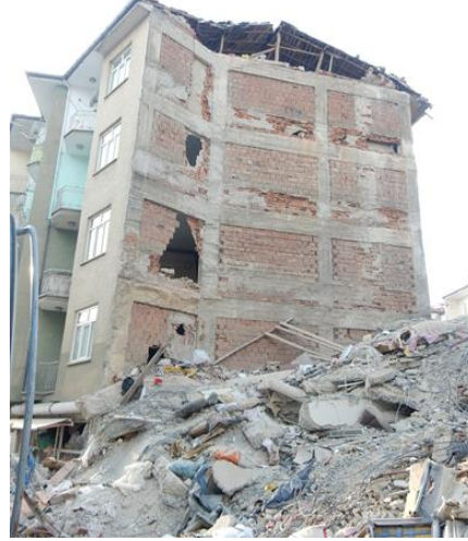
Şekil 36. Elazığ'da yıkılan betonarme binalar
