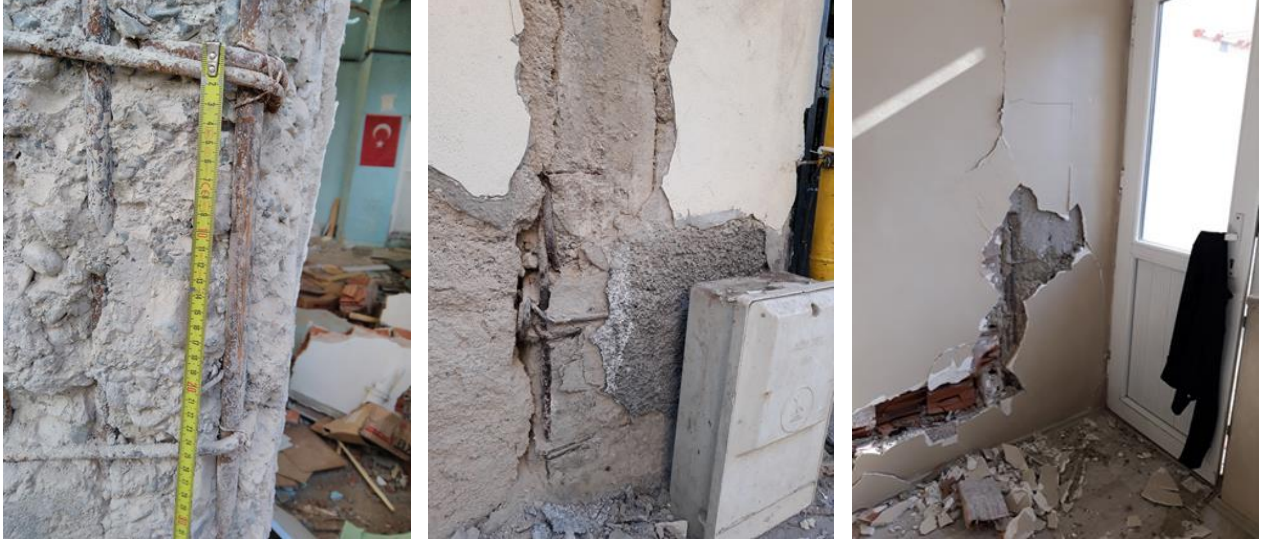
Şekil 39. Düz donatı kullanımının yarattığı aderans problemleri
