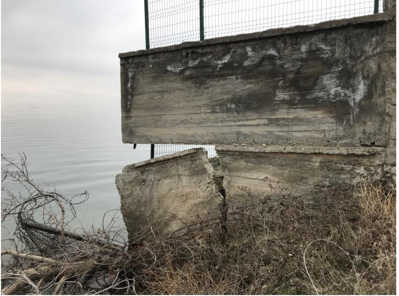
Şekil 18. Yanal deformasyon sonucu hasara uğrayan sınır duvarı
