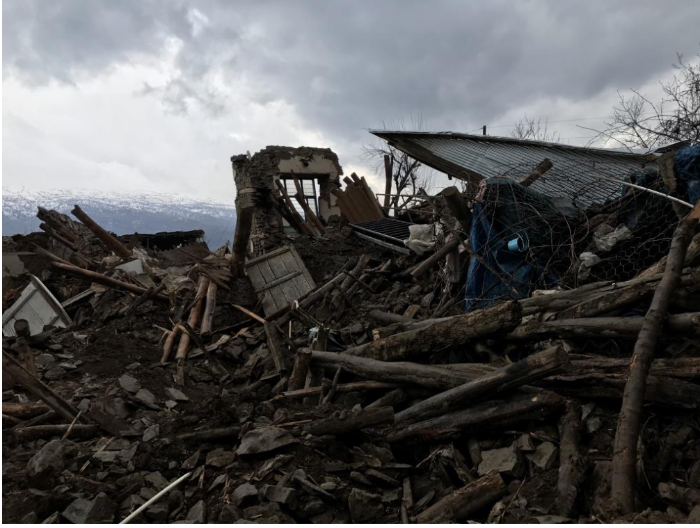
Şekil 28. Deprem etkisi ile yıkılmış binalar
