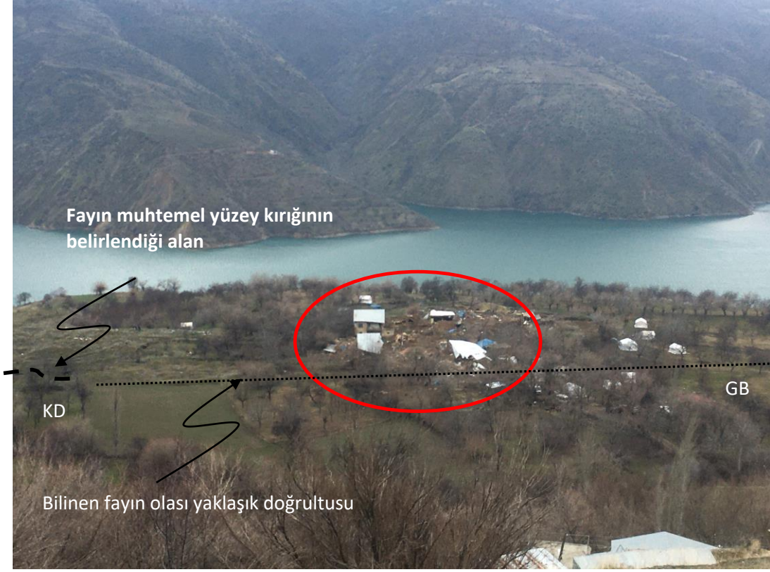
Şekil 26. Deprem etkisi ile yıkılmış binaların uzaktan görünümü
