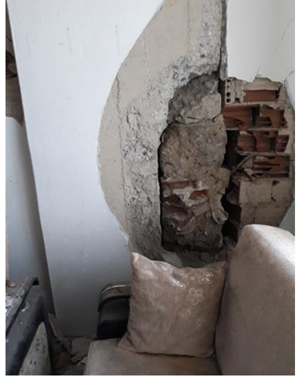
Şekil 38. Binalar arasındaki yetersiz derz boşlukları nedeniyle oluşan bölme duvar ve kolon hasarı
