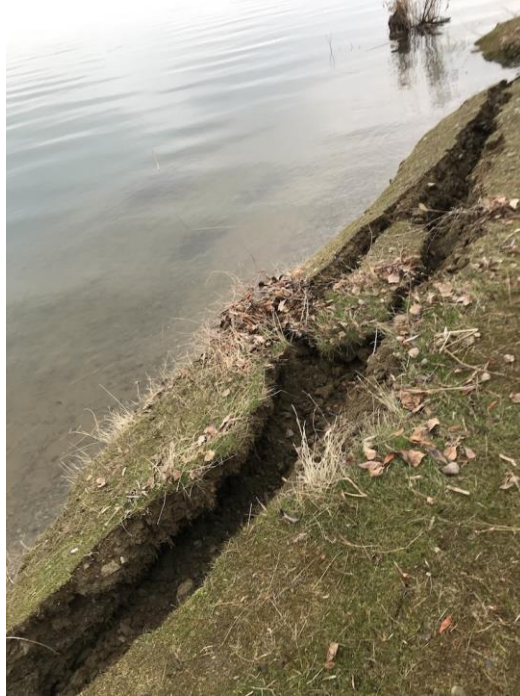
Şekil 17. Bölgede oluşan yanıl deformasyon ve göçmeler
