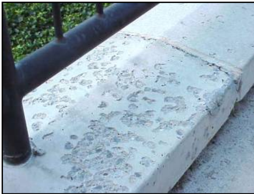
Resim 32-33: Donma-Çözülme etkisi sonucu betonun görünümü
