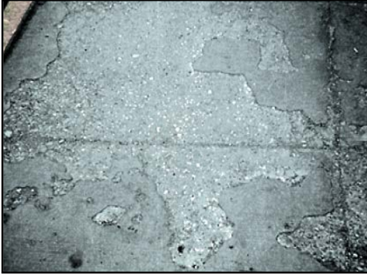
Resim 13-14: Beton yüzey harcında bozulma
