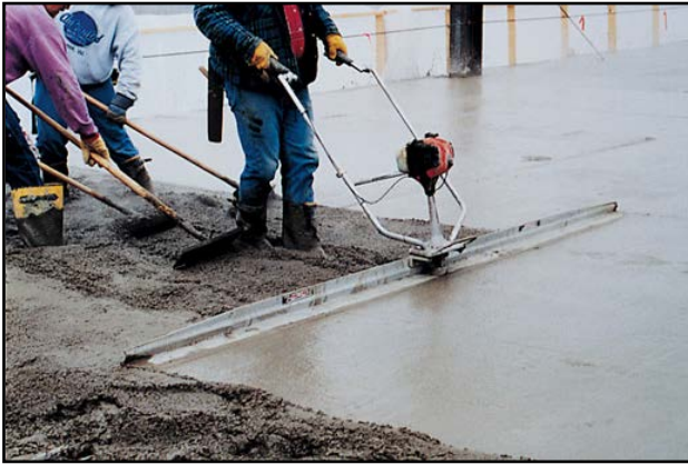
Resim 36-37: Beton yüzeyinde düzleme ve bitirme işlemleri
