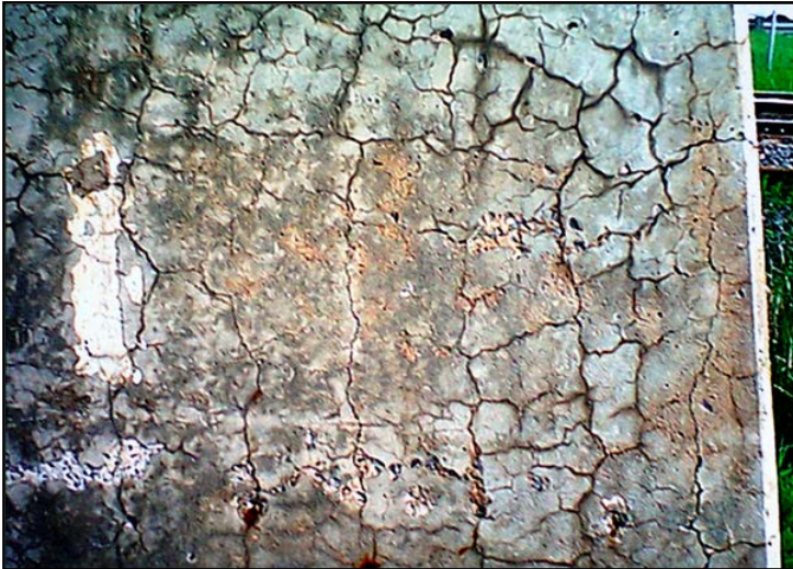
Resim 38-39: Alkali-silika reaksiyonu sonucu betonun görünümü
