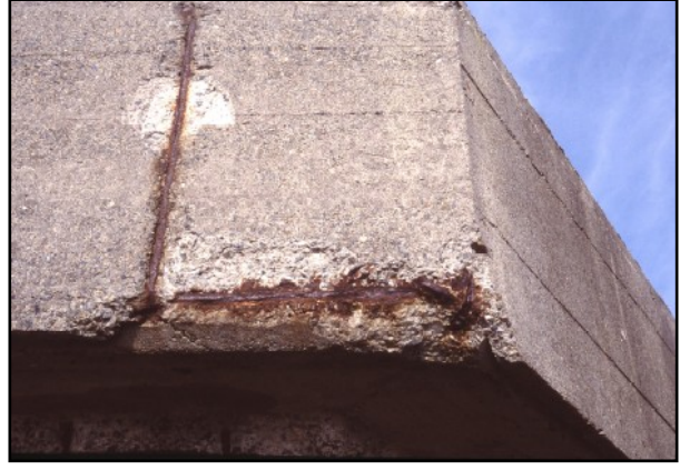
Resim 30-31: Karbonatlaşma etkisi sonucu beton görünümü
