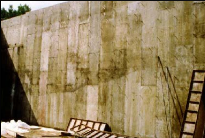
Resim 16-17: Soğuk Derz-Beton dökümü sırasında uygulamadaki gecikme sebebiyle iki tabaka arasında meydana gelen derz veya süreksizliktir.
