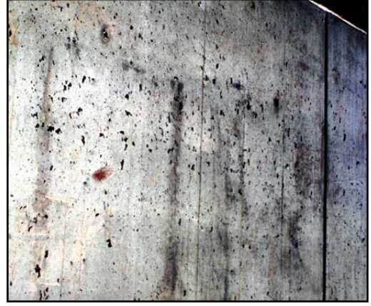
Resim 22-23: Beton yüzeyinde boşluklar- Çapı 15 mm'yi geçmeyen ve beton yüzeyinde dağınık olarak görülen boşluklardır. Kalıbın üst kısmında daha sık görülür.Yapıya zararları yoktur.
