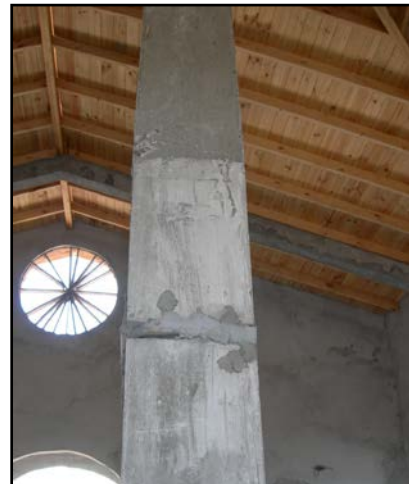
Resim 16-17: Soğuk Derz-Beton dökümü sırasında uygulamadaki gecikme sebebiyle iki tabaka arasında meydana gelen derz veya süreksizliktir.
