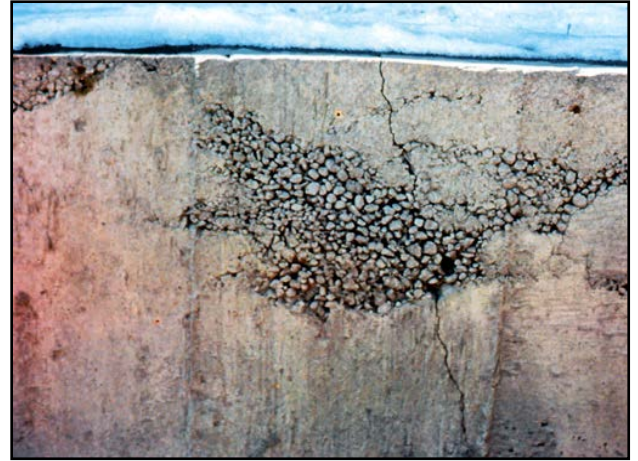
Resim 18-19: Petek dokusu- Daha çok perde, kolon-kiriş kesişim bölgelerinde ayrışmadan dolayı oluşan hasardır.
