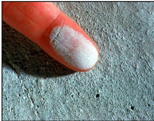
Resim 1: Beton yüzeyindeki su/çimeto oranının artması yüzey dayanımını düşürür.
