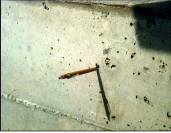
Resim 22-23: Beton yüzeyinde boşluklar- Çapı 15 mm'yi geçmeyen ve beton yüzeyinde dağınık olarak görülen boşluklardır. Kalıbın üst kısmında daha sık görülür.Yapıya zararları yoktur.
