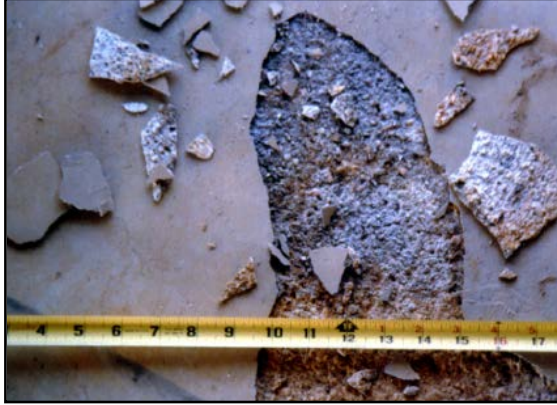
Resim 20-21: Tabakalaşma- Yüzeyin 3-6 mm'lik üst yüzeyinde erken ve kötü bitirme işlemi sonucu oluşan hasardır.
