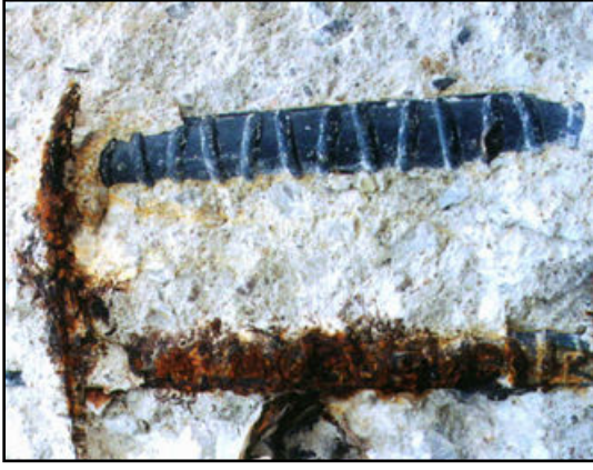
Resim 30-31: Karbonatlaşma etkisi sonucu beton görünümü
