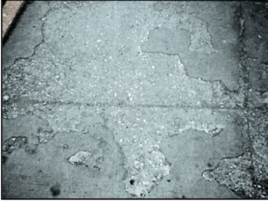
Resim 13-14: Beton yüzey harcında bozulma
