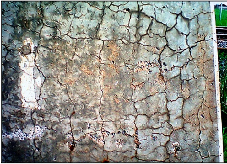
Resim 38-39: Alkali-silika reaksiyonu sonucu betonun görünümü
