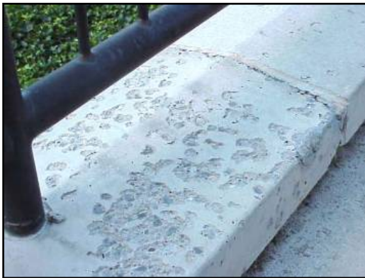
Resim 32-33: Donma-Çözülme etkisi sonucu betonun görünümü
