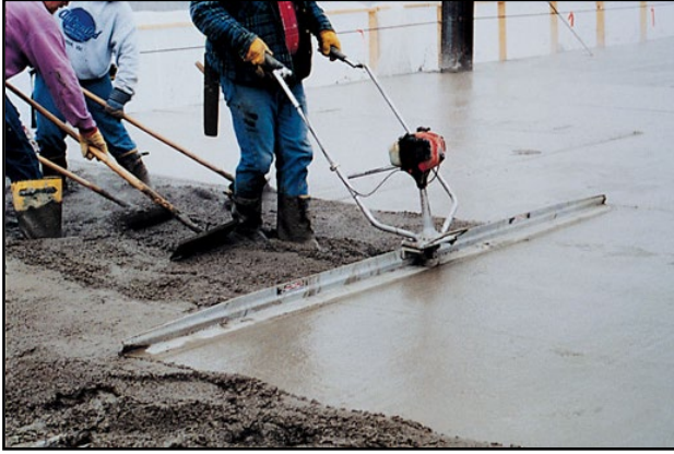
Resim 36-37: Beton yüzeyinde düzleme ve bitirme işlemleri
