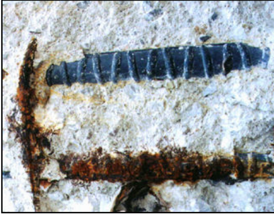
Resim 30-31: Karbonatlaşma etkisi sonucu beton görünümü
