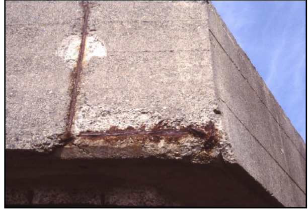
Resim 30-31: Karbonatlaşma etkisi sonucu beton görünümü
