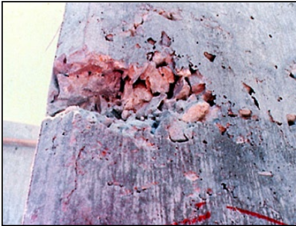
Resim 18-19: Petek dokusu- Daha çok perde, kolon-kiriş kesişim bölgelerinde ayrışmadan dolayı oluşan hasardır.
