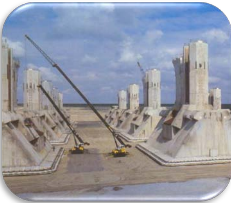
Resim 7: YFC çimento ile yapılan sel bariyerleri, Oosterschelde, Hollanda
