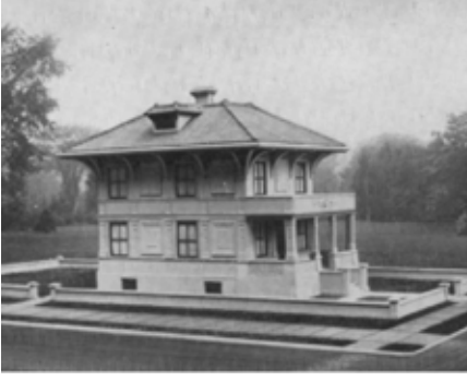
Resim 7. Edison'un tasarladığı betonarme evin inşası
