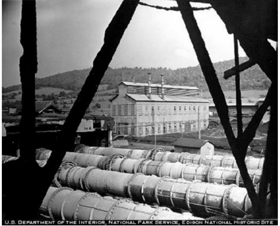
Resim 5. Edison Çimento Fabrikası'ndaki Edison tarafından tasarlanmış döner fırınlar
